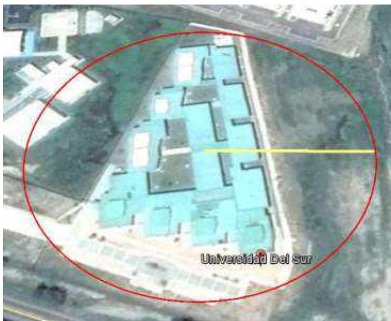
Infraestructura Educativa del Sur ubicada en el municipio de Suan
