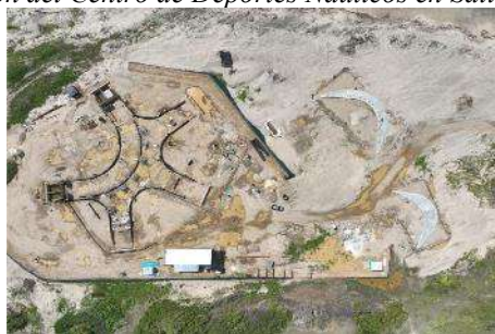
Ilustración 64. Construcción del Centro de Deportes Náuticos en Salinas del Rey, Juan de Acosta
