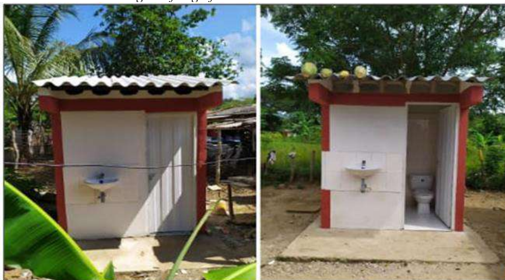
Ilustración 103. Registro fotográfico de una de las baterías sanitarias construidas
