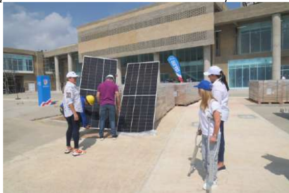
Ilustración 98. Inspección de Paneles Fotovoltaicos en Hospital Juan Domínguez Romero.
