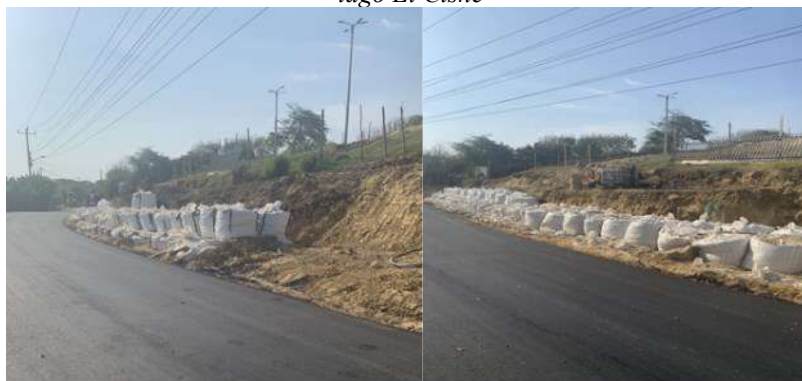
Ilustración 81. 2.5.1.2.5 Obras de emergencia Habilidad en la antigua vía a Puerto Colombia a la altura del lago El Cisne
