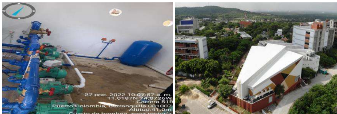
Ilustración 30. Registros fotográficos de las adecuaciones realizadas
