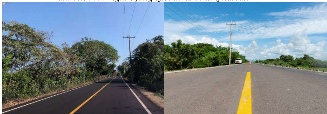
Ilustración 77.. Registro fotográfico de las obras ejecutadas
