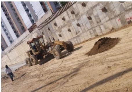
Ilustración 144 Mejoramiento del corredor vial Circunvalar– Puerto Colombia, tramo 1 – UF 2
