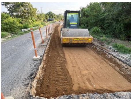
Ilustración 146 Mejoramiento, rehabilitación y mantenimiento de la red vial en el Atlántico
