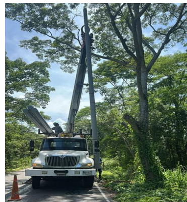
Ilustración 119 Trabajos de instalación de luminarias en Usiacurí
