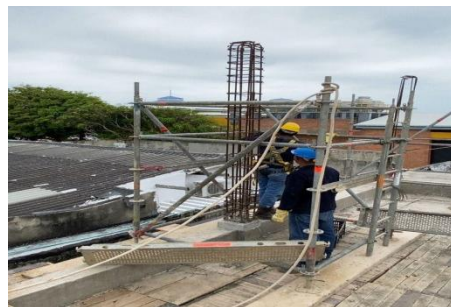
Ilustración 64 Adecuación de infraestructura en la Casa Láscar
