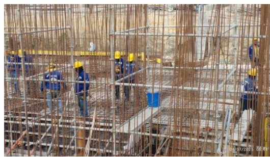
Ilustración 115 Avance proyecto Acueducto Regional del Norte
