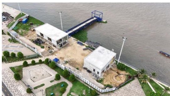
Ilustración 114 Avance proyecto Acueducto Regional del Norte
