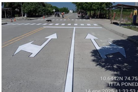
Ilustración 140 Demarcación de flechas y línea central en vía del municipio de Ponedera
