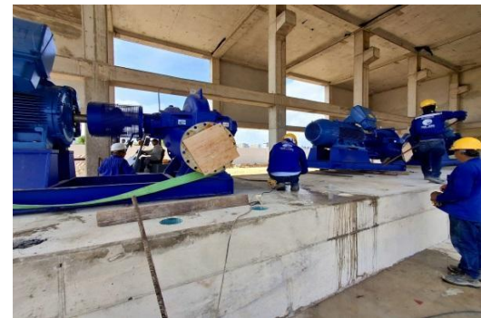
Ilustración 117 Avance proyecto Acueducto Regional del Norte
