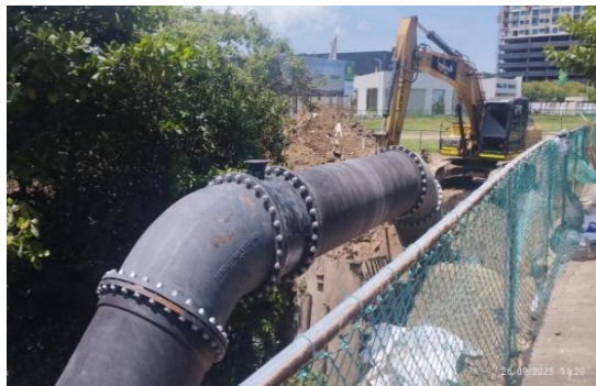
Ilustración 116 Avance proyecto Acueducto Regional del Norte
