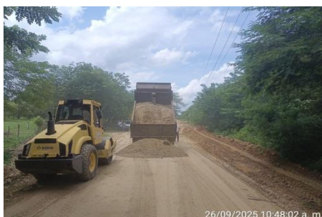
Ilustración 96 Rehabilitación de vías en el municipio de Piojó
