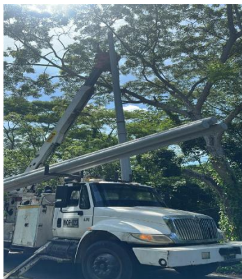
Ilustración 118 Instalación de luminarias en la vía Usiacurí– Baranoa
