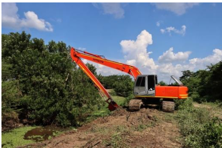
Ilustración 92 Limpieza de canal de drenaje.
