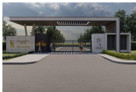
Ilustración 14 Pórticos y cerramientos en la Sabanalarga de la Universidad del Atlántico
