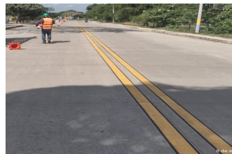
Ilustración 141 Demarcación de doble línea central en vía del municipio de Ponedera
