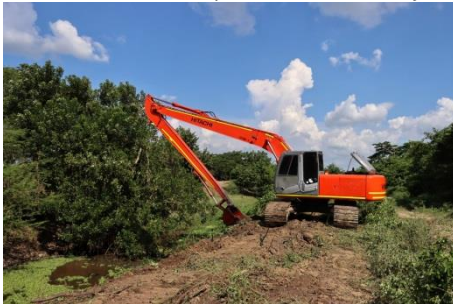
Ilustración 105. Limpieza canal de drenaje.
