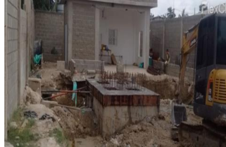
Ilustración 126 Avance de Obra proyecto Alcantarillado Palmar Cuenca 3
