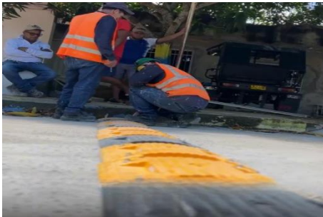
Ilustración 148 Instalación de reductores de velocidad en Santo Tomás
