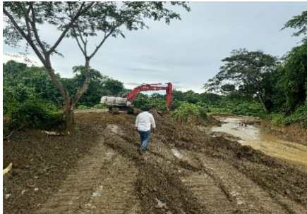
Ilustración 109 Obras de limpieza de arroyos en el municipio de Juan de Acosta
