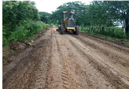
Ilustración 110 Rehabilitación de Vías en el municipio de Suán
