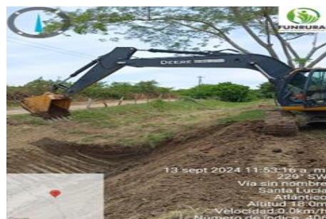
Ilustración 172. Trabajos en el distrito de adecuación de tierras.
