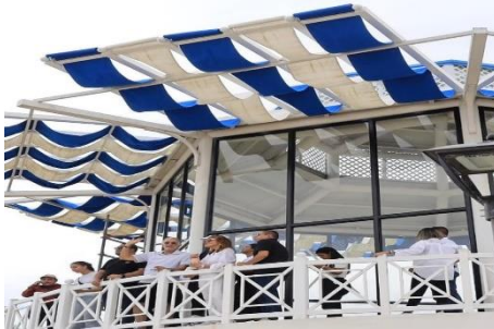
Ilustración 138. Muelle 1888 - Puerto Colombia.
