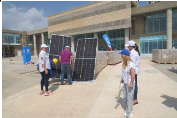
Ilustración 96. Inspección de Paneles Fotovoltaicos en Hospital Juan Domínguez Romero.
