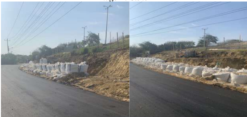
Ilustración 79. 2.5.1.2.5 Obras de emergencia Habilitación en la antigua vía a Puerto Colombia a la altura del lago El Cisne
