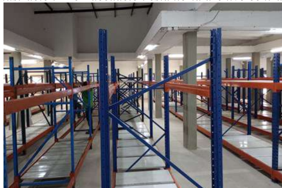
Ilustración 116 Adecuación estantería archivo central.
