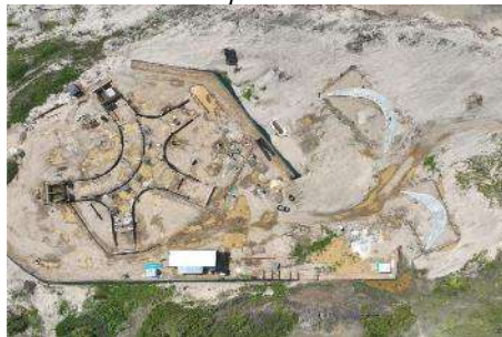
Ilustración 62. Construcción del Centro de Deportes Náuticos en Salinas del Rey, Juan de Acosta
