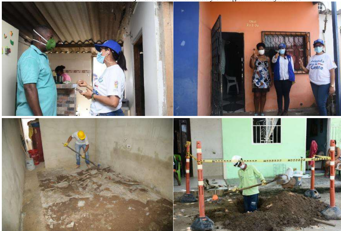
Ilustración 94. Obras de mejoramiento terminadas y entregadas a beneficiarios
