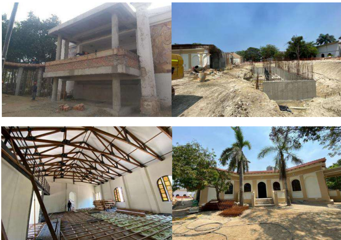
Ilustración 29. Ilustración 3. Registros fotográficos de las adecuaciones realizadas en la sede Bellas Artes
