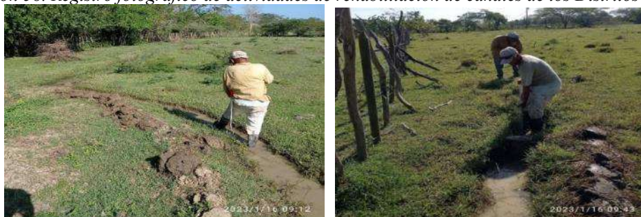
Ilustración 58. Registro fotográfico de actividades de rehabilitación de canales de los Distritos de Riego.
