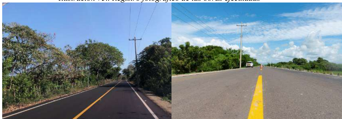
Ilustración 75.. Registro fotográfico de las obras ejecutadas
