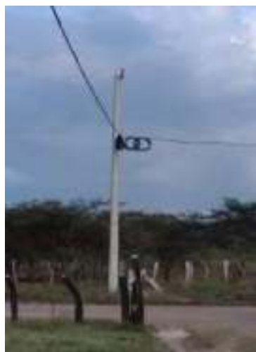
Tendido de acometidas de baja tensión para usuarios Santa Lucía, Proyecto de Electrificación Rural Sector Loro
