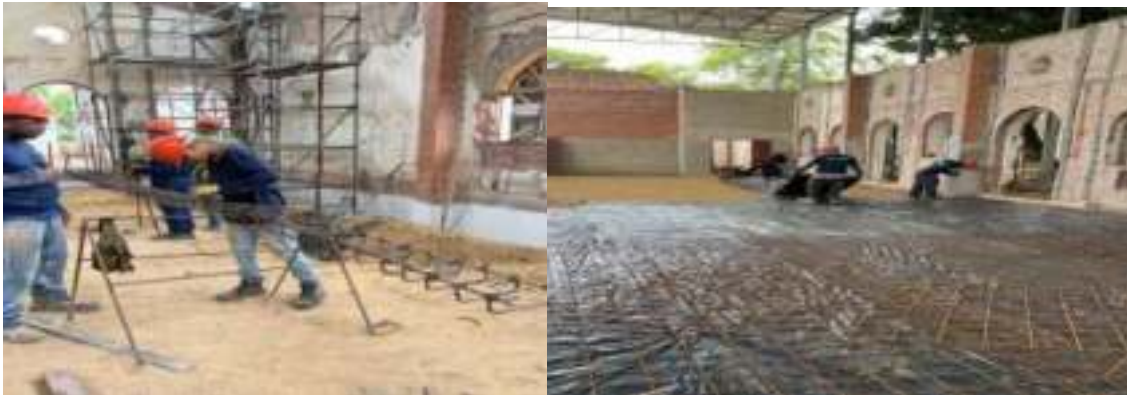
APERTURA DE REGATAS PARA REFORZAMIENTO DE MUROS PERIMETRALES CON PLATINAS EXTERIOR E INTERIOR, LEVANTE EN LADRILLO ESTRUCTURAL DE MURO, RELLENO Y COMPACTACIÓN EN EXCAVACIONES Y ÁREA DE PLANTILLA, ESCARIFICACIÓN DE PAÑETE, PAÑETE EN MURO Y MACHONES, CONFORMACIÓN DE ARCO EN VANO BLOQUE ALEJANDRO OBREGÓN
