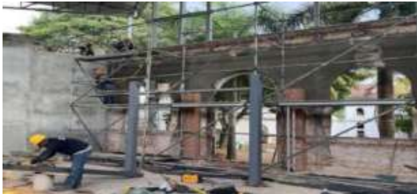
INSTALACION ESTRUCTURA METALICA MEZZANINE BLOQUE AULA MAGNA
