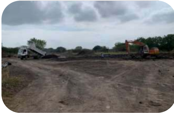
Registro fotográfico ejecución del proyecto Rehabilitación del sistema de tratamiento de aguas residuales, municipio de Candelaria. Avance 40%.
