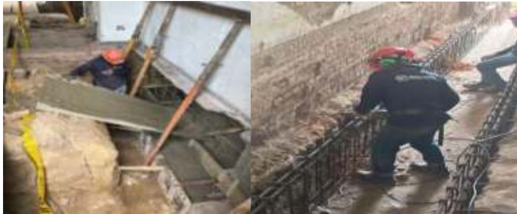
CONFORMACIÓN DE ACERO DE REFUERZO PARA CIMENTACIÓN, VACIADO EN CONCRETO PARA CIMENTACIÓN NUEVA, EXCAVACIONES Y RETIRO DE MATERIAL PARA REFORZAMIENTO ESTRUCTURAL BLOQUE PATRIMONIAL (MUSEO)
