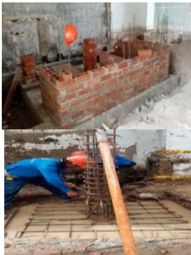
LEVANTE EN LADRILLO BAÑO LOBBY
