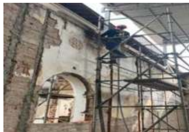
REGATA E INSTALACIÓN PLATINAS ANCLAJE DE MUROS PERIMETRALES INTERNOS Y EXTERNOS PEDRO BIAVA.
