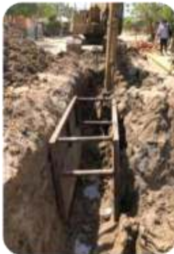
Registro fotográfico ejecución del proyecto Construcción sistema de Alcantarillado cuenca 2 municipio de Palmar de Varela Departamento del Atlántico. Avance 47%.
