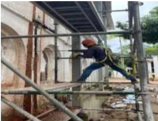
REGATA E INSTALACIÓN PLATINAS ANCLAJE DE MUROS PERIMETRALES INTERNOS Y EXTERNOS PEDRO BIAVA.
