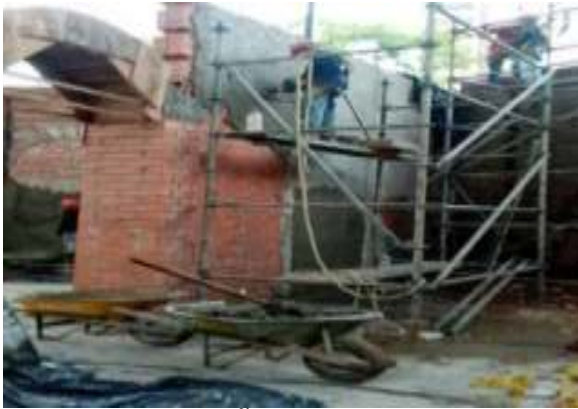
LEVANTE Y PAÑETE MUROS AULA MAGNA
