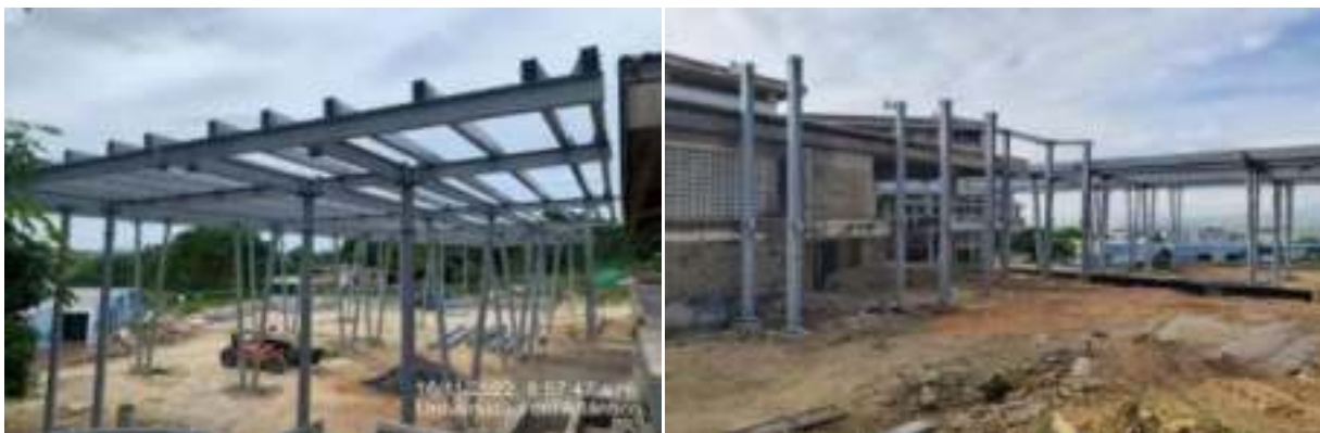
INSTALACIÓN DE ESTRUCTURA METÁLICA COMEDOR
