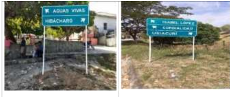
Ilustración 34 Instalación señales SI-05
