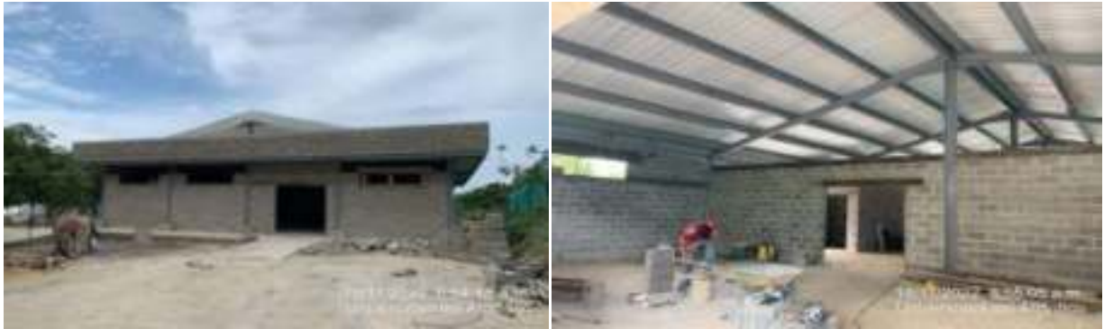
CONSTRUCCIÓN OFICINA DE SERVICIOS GENERALES
