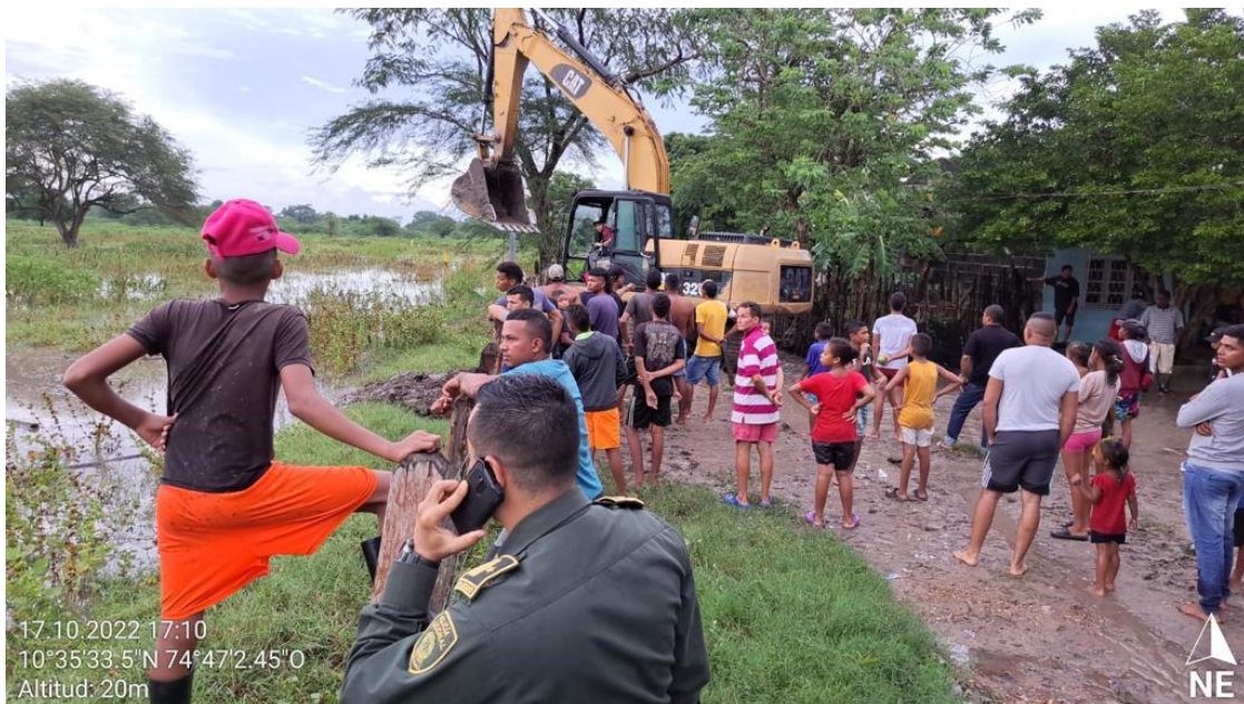
Maquinaria Amarilla realizando intervención de arroyos.
