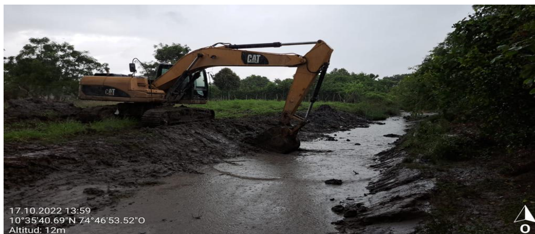
Maquinaria Amarilla realizando labores de rehabilitación y limpieza de canales en el sur del Departamento del Atlántico.
