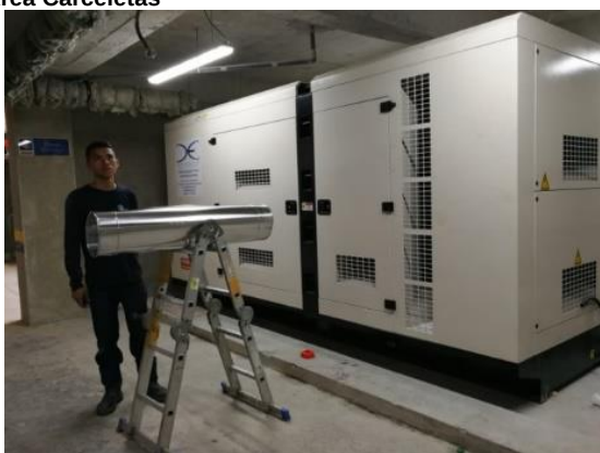
Instalación planta Eléctrica
