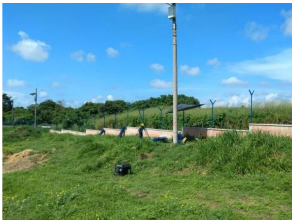
Malla perimetral terminada
