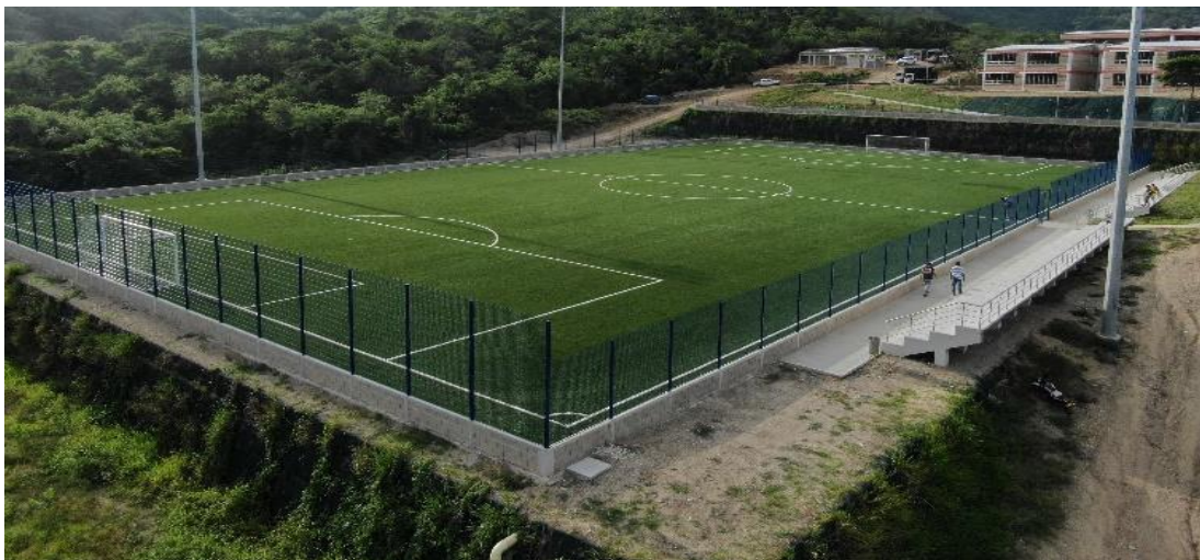
Cancha Múltiple Corregimiento de Carreto Municipio de Candelaria.
