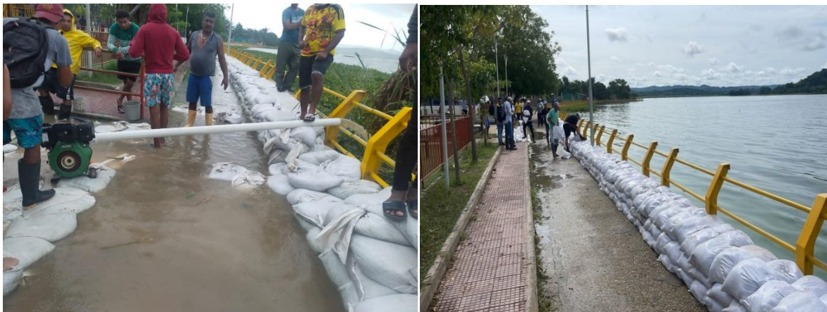
Obras de mitigación en el Corregimiento de la Peña para prevenir inundaciones por cuerpos de agua del Departamento del Atlántico.
