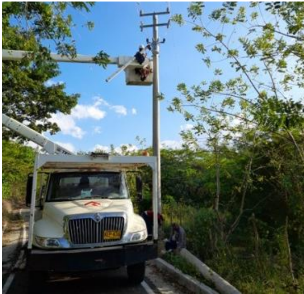
Instalación de transformadores para alimentar usuarios Usiacurí, Proyecto de Electrificación Rural Sector Luriza Tramo II
