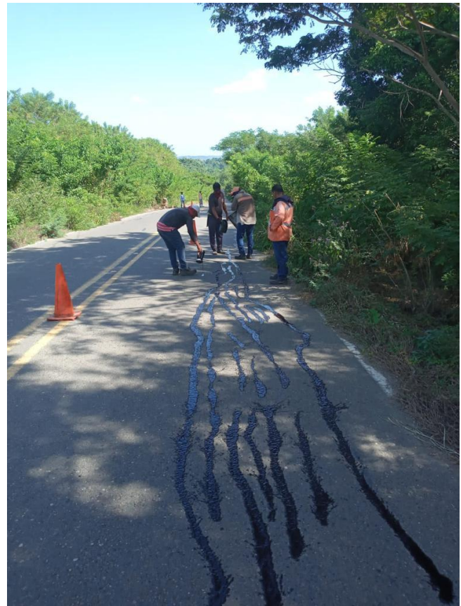
Rocería en la vía Juan Mina -- Cuatro Bocas y sello de fisuras en la vía Tubará – Cuatro Bocas
