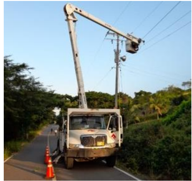
Instalación de transformadores para alimentar usuarios Usiacurí, Proyecto de Electrificación Rural Sector Luriza Tramo II
