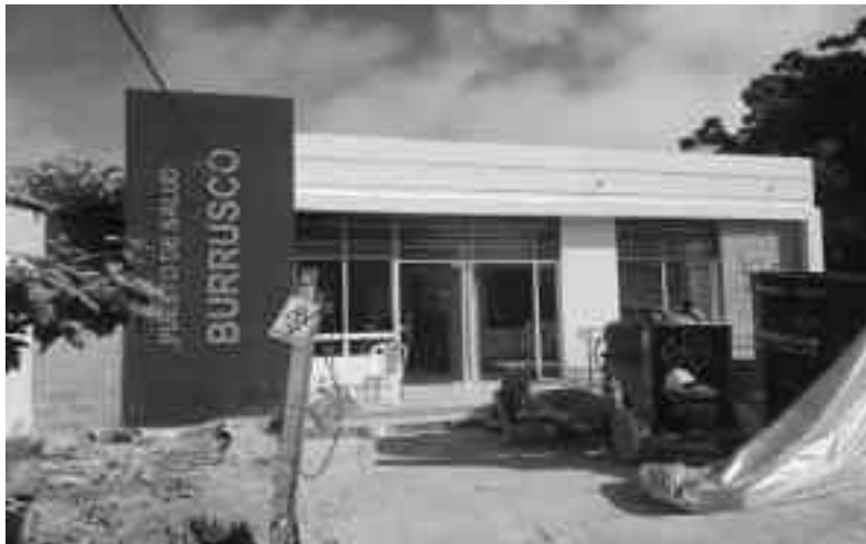
Construcción Centro de Atención Primaria CAPA Burrusco
