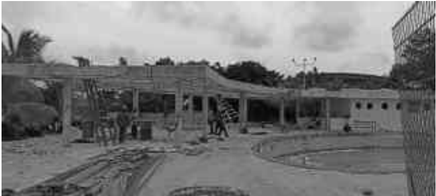
Plaza Central de Soledad Municipio de Soledad – 80% de ejecución
