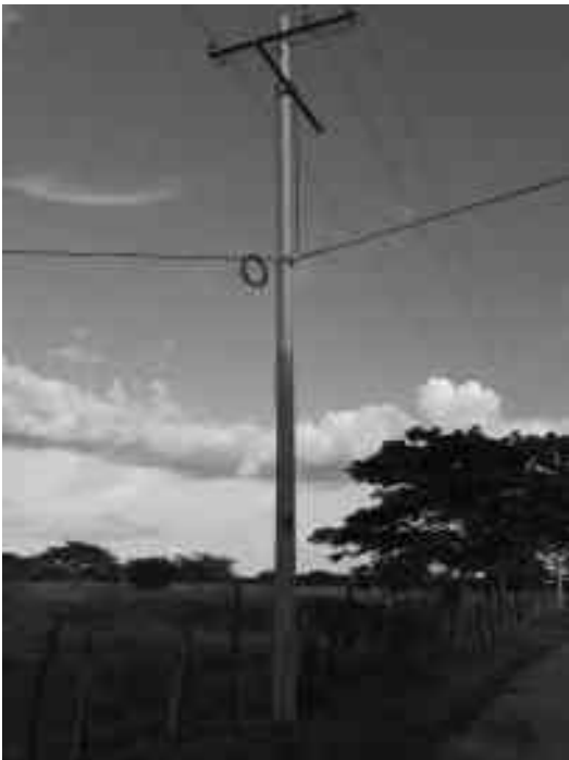
Instalación de acometidas de baja tensión para usuarios Manatí, Proyecto de Electrificación Rural Sector Madre Teresa
