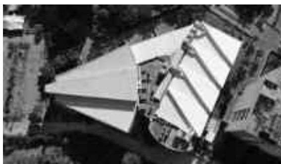
IMPERMEABILIZACIÓN CENTRO CULTURAL
