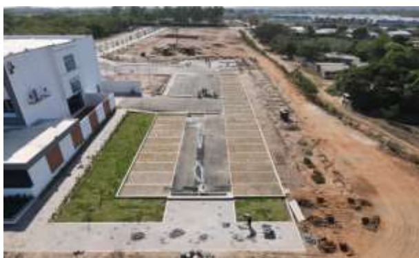
Panorámica Fachada Lateral
