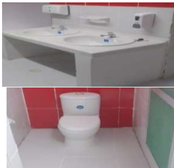
Construcción de nuevos baños
