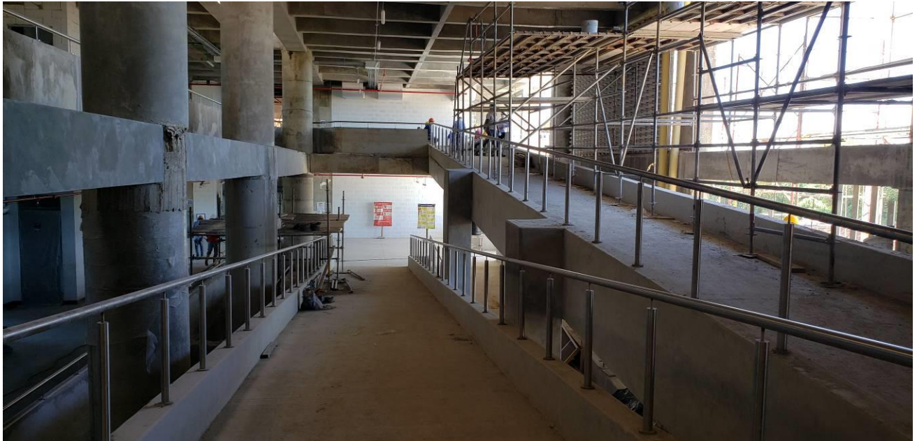
Rampa que Comunica Segundo y Tercer Piso
