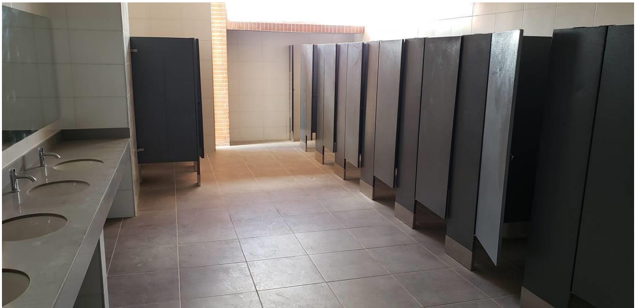
Batería de Baños Damas
