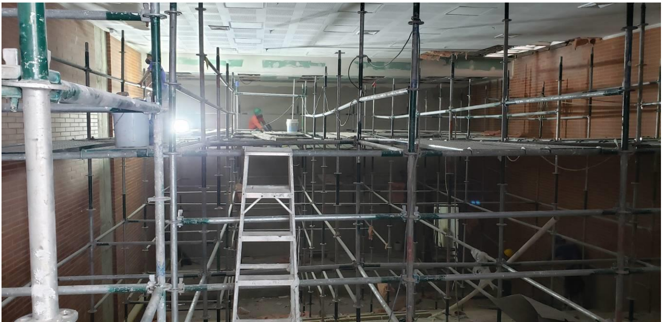
Aula Mayor Capacidad 164 Personas Área 210 M2
