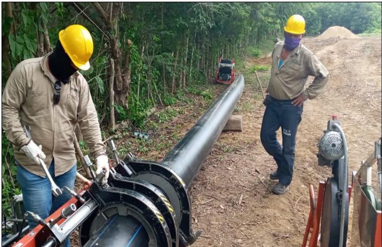
Descripción: Empalme de tubería
