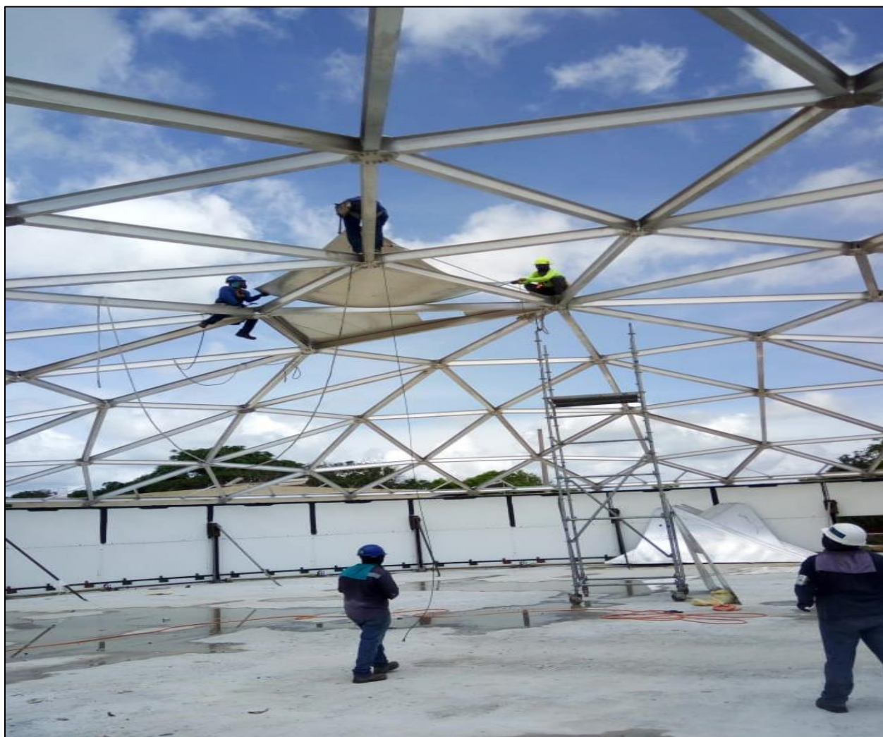
Descripción: instalación tanque de almacenamiento vidrio fusionado
