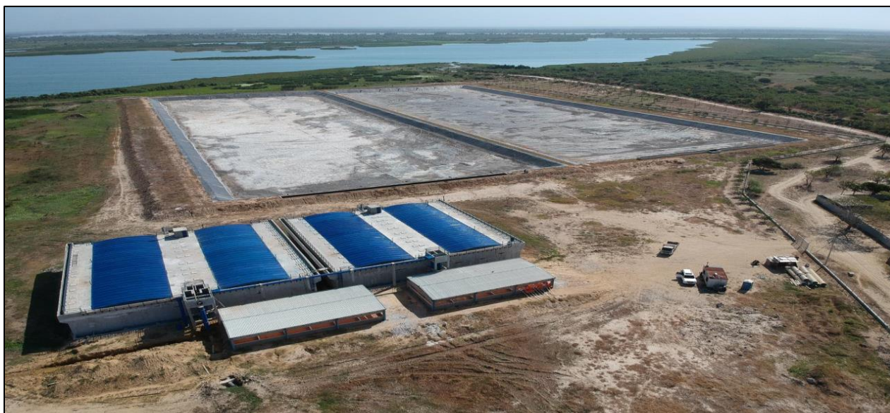
Descripción: VISTA DE LA Planta de Tratamiento de Aguas Residuales-Malambo
