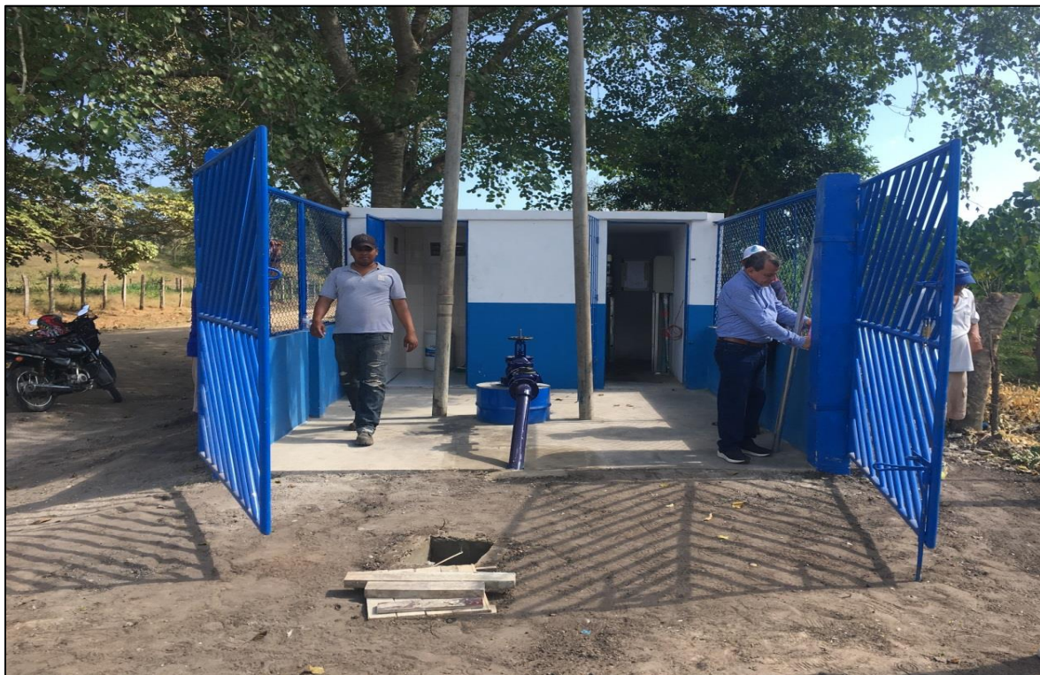
Descripción: Cerramiento pozo profundo
