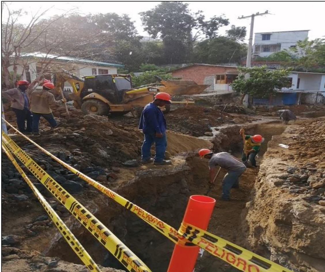
Descripción: instalación tubería
