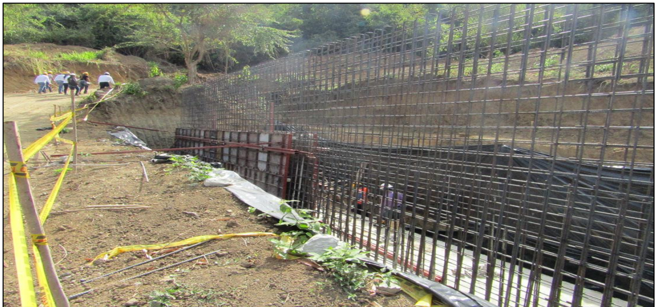
Descripción: detalle constructivo – PTAR Piojó
