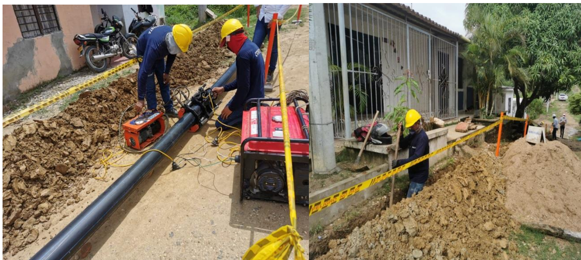
Descripción: instalación de tubería
