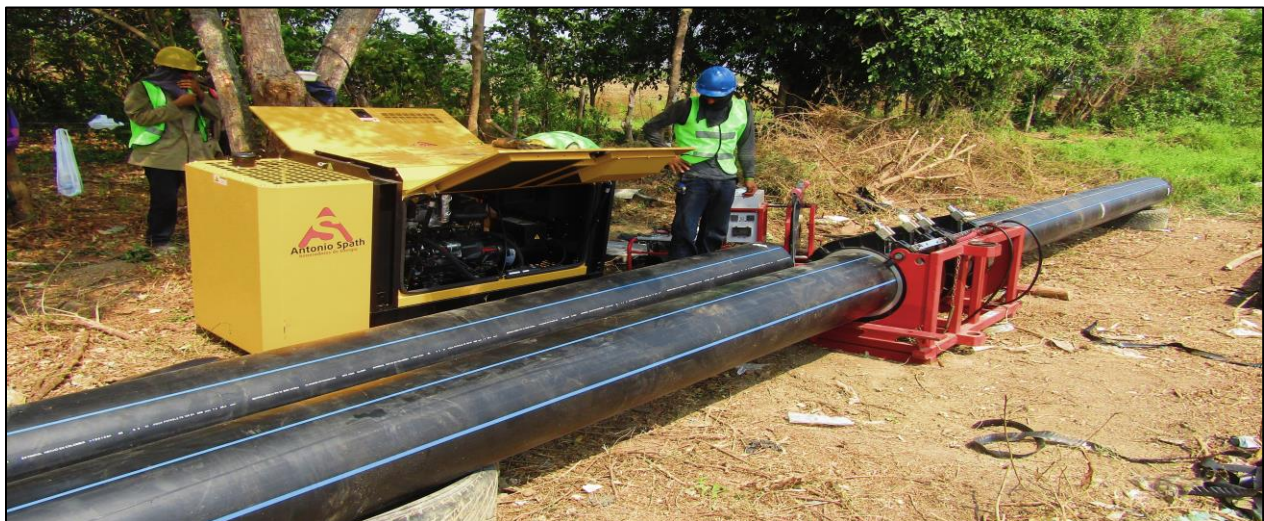
Descripción: empalme de tubería
