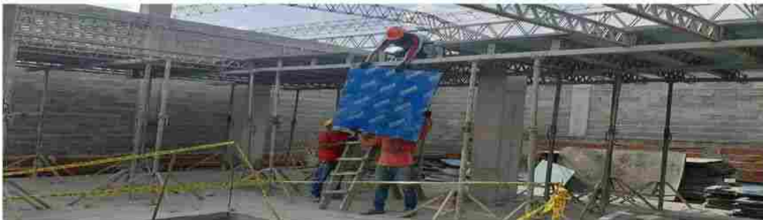
Datos generales del contrato y registro fotográfico
