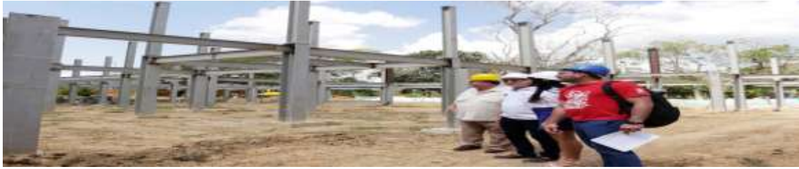
Nodo Del Sena En Sabanalarga Avanza 60 % En Trabajos Estructurales
