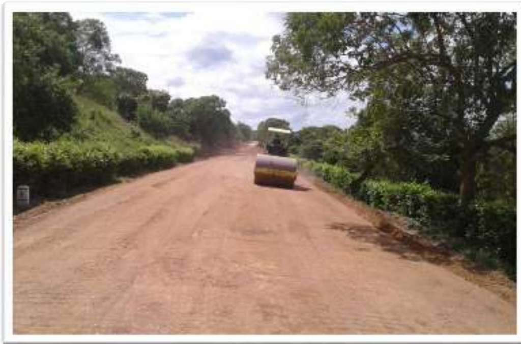
COMPACTACIÓN DE TERRAPLEN
