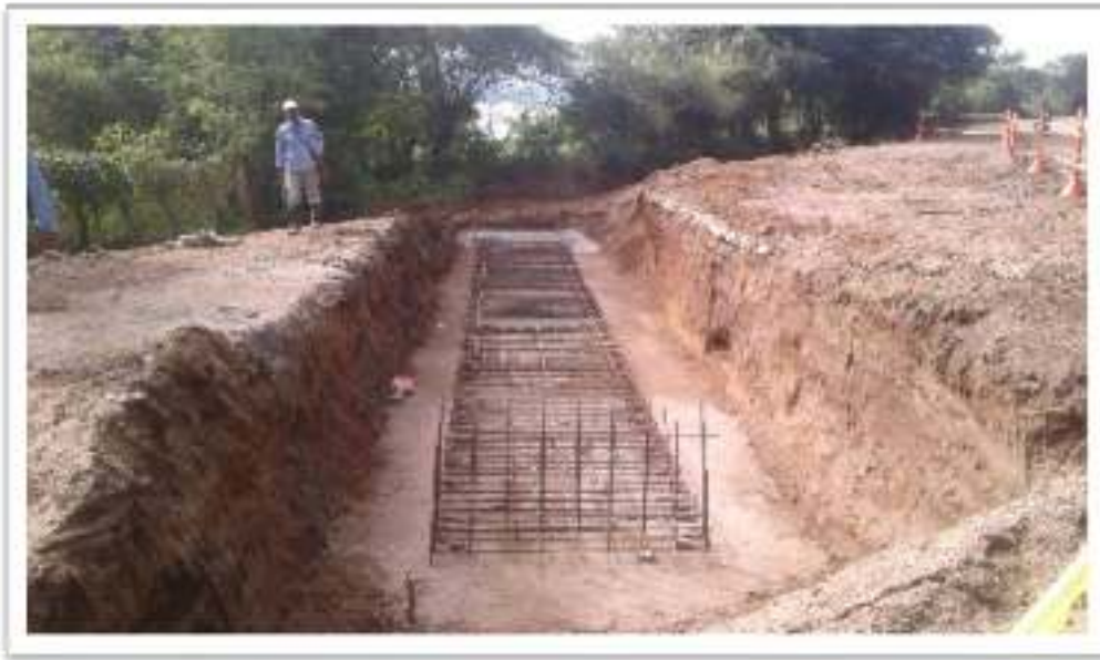
ACERO DE REFUERZO FY=420 Mpa PSI LOSA FONDO DEL BOX CULVERT N° 25
