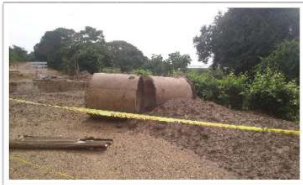
REMOCION DE ALCANTARILLAS DEL BOX CULVERT N° 26
