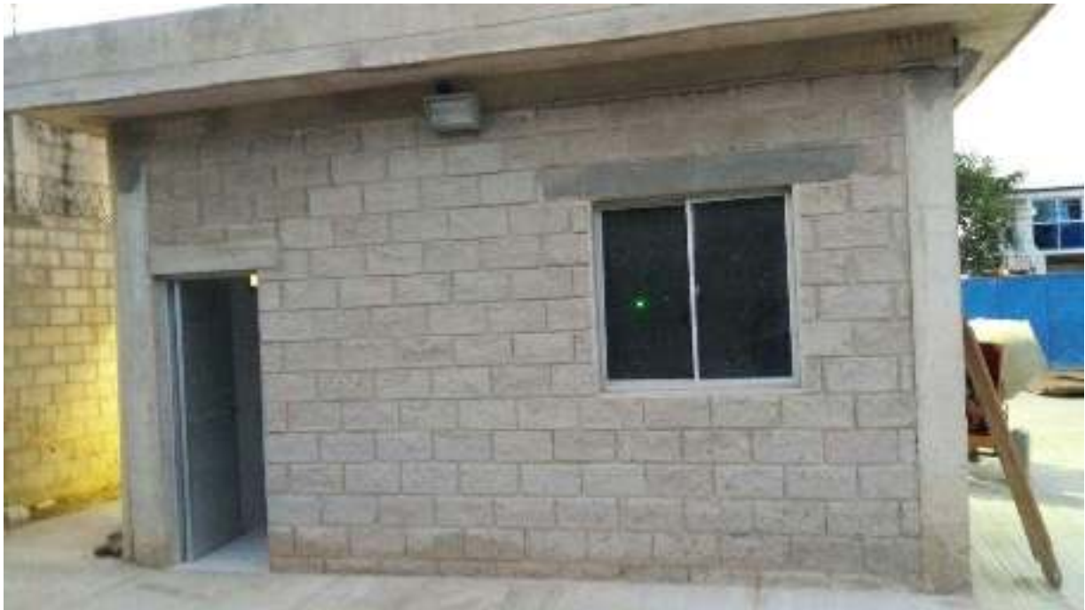
ESTACION ELEVADA DE SALGAR
