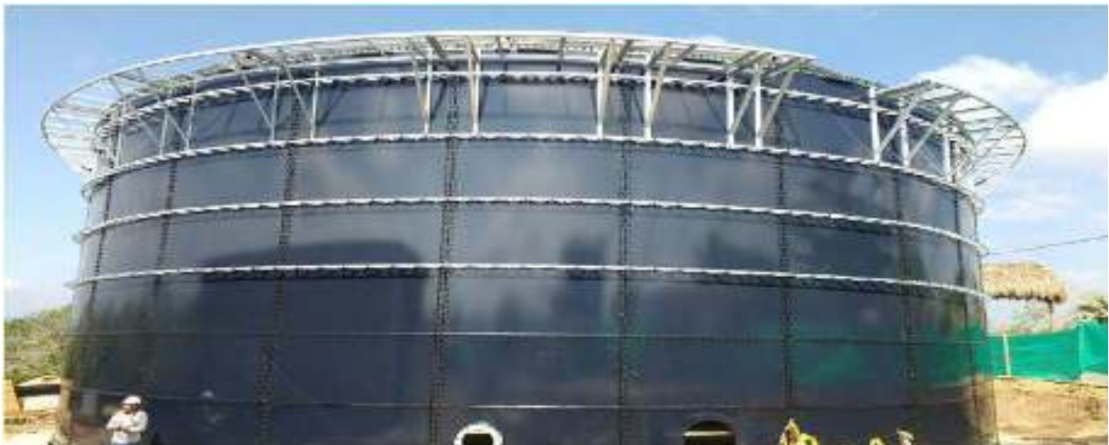
TANQUE DE ALMACENAMIENTO ACUEDUCTO COSTERO
