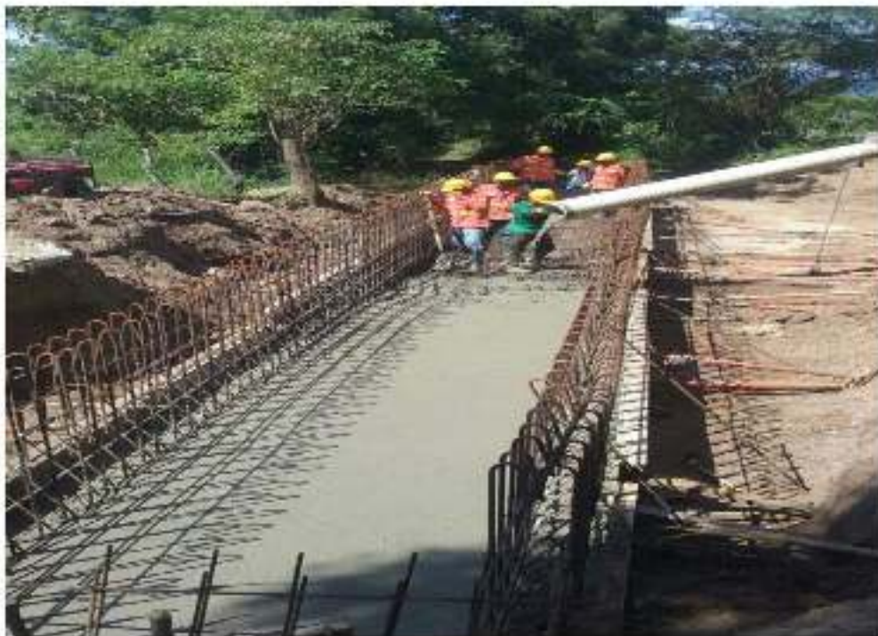
ACERO DE REFUERZO FY=420 Mpa PSI LOSA FONDO DEL BOX CULVERT N° 25
