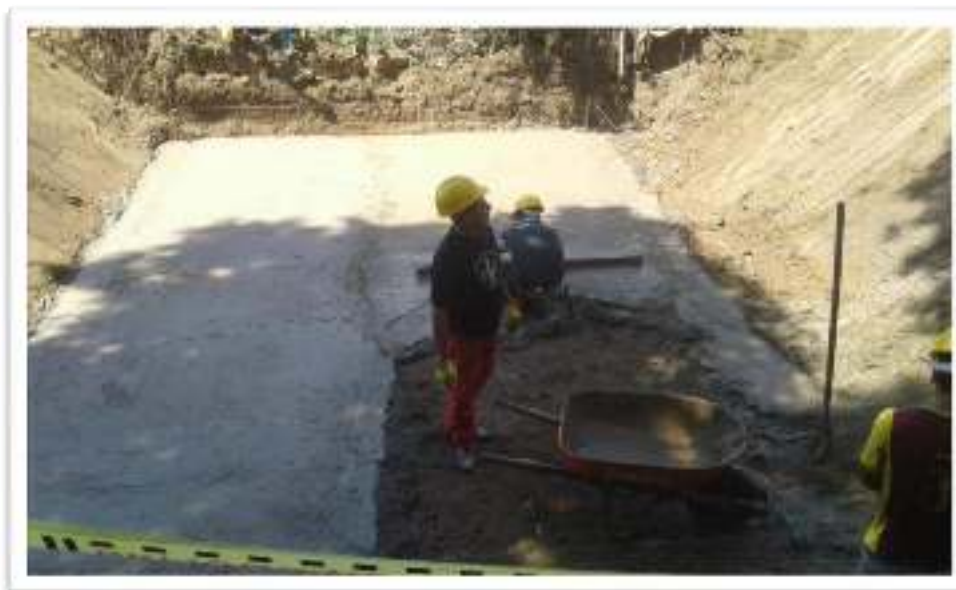
CONCRETO CLASE F DE 2000 PSI PARA SOLADO LIMPIEZA BOX CULVERT N° 26
