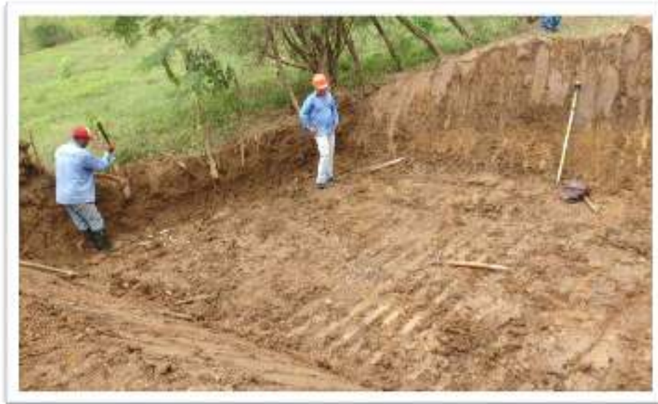
EXCAVACION MECANICA BOX CULVERT N° 25
