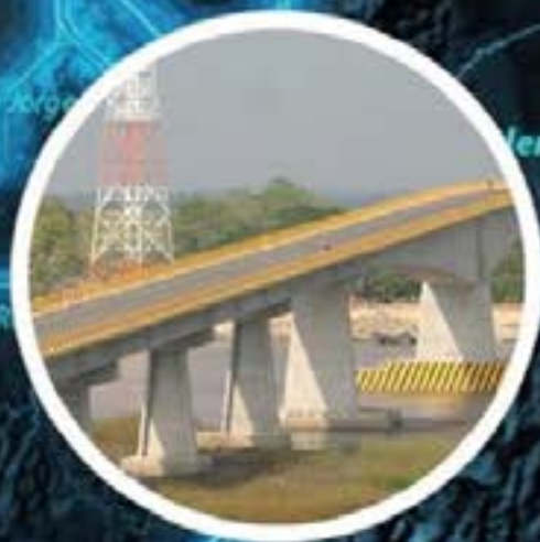
Puente de la Hermandad con carretera Salamina - Fundación
