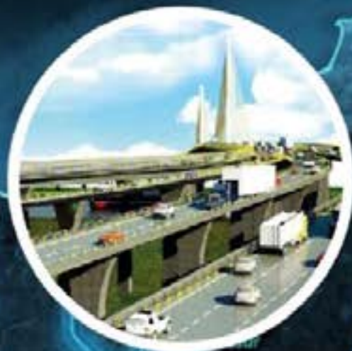
Nuevo Puente Pumarejo
