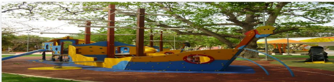
Obras de reconstrucción del Parque "Tomas Suri Salcedo" en Barranquilla.
