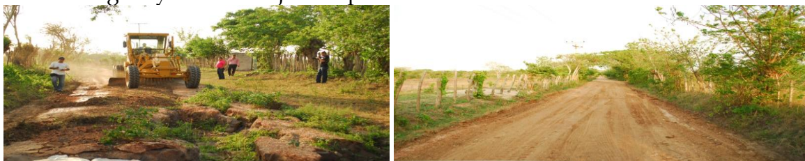
Fotos rehabilitación de vías terciarias.
