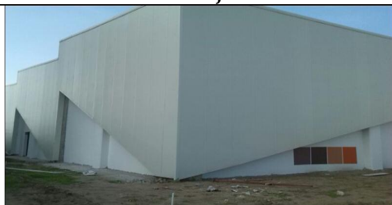
Adecuación de acabados en la fachada del centro de convenciones
