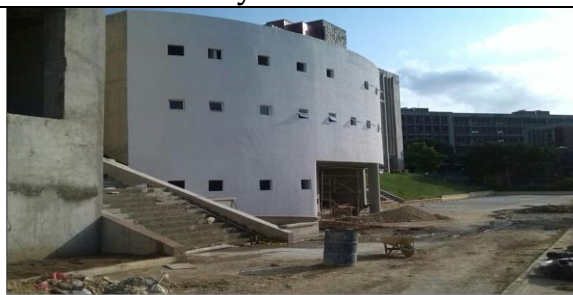
Adecuación zona acceso al auditorio
