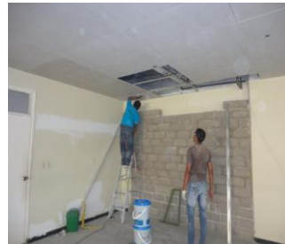
Muro de Cerramiento en Mampostería
