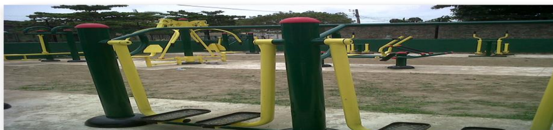
Construcción e instalación del Parque Biosaludable en el municipio de Suán.
