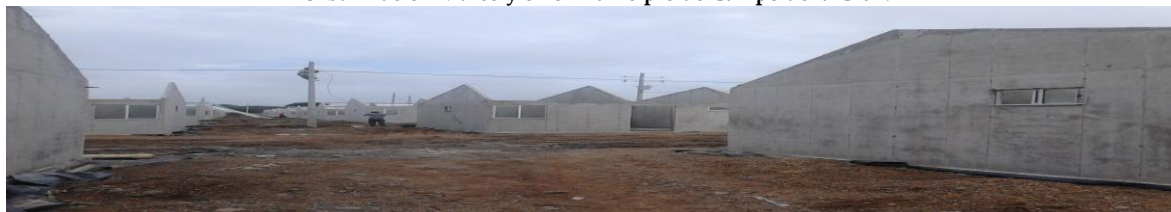
Construcción de viviendas en el municipio de Manatí.
