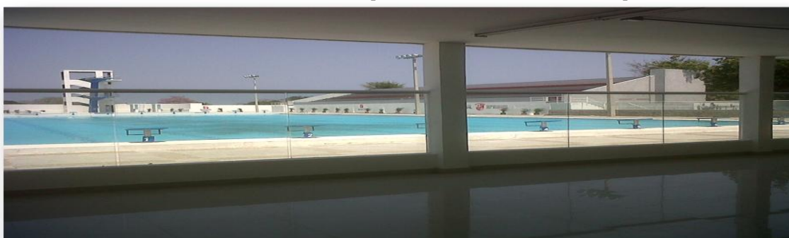
Obras complementarias de la Piscina Olímpica en Barranquilla.
