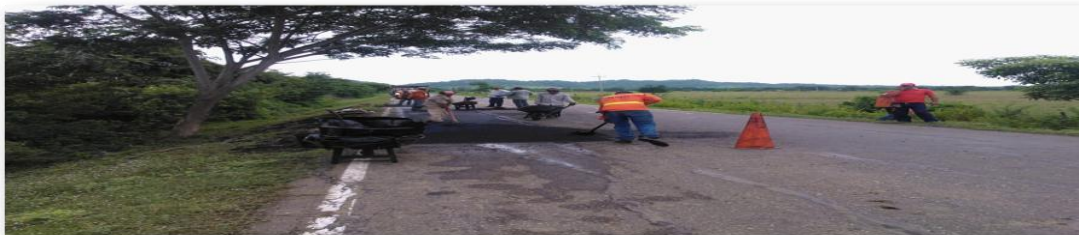
Mantenimiento de la vía Repelón-Villa Rosa-Puerto Limón.
