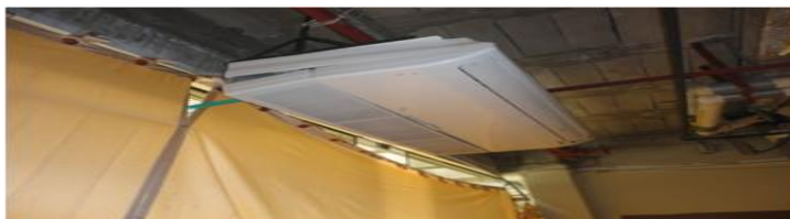
Retiro de equipos de aire acondicionado
