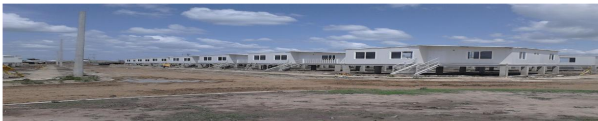
Construcción de viviendas en el municipio de Candelaria.
