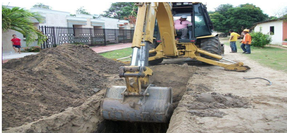
Excavaciones para redes de alcantarillado
