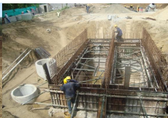
Construcción de Tanque
