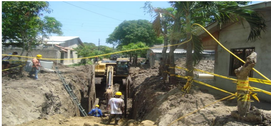
Excavaciones profundidades mayores a 6 metros.
