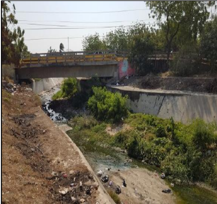
Vertimientos de aguas residuales a arroyo límitrofe con Santo Tomas
