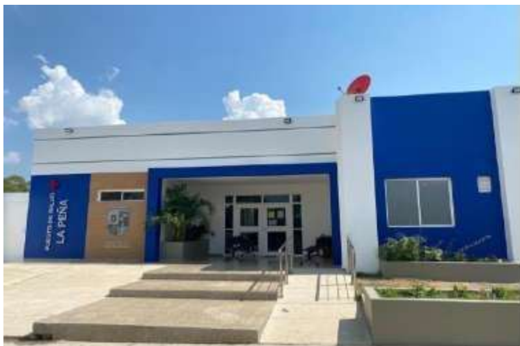
Fuente: Interventoría de Obras
