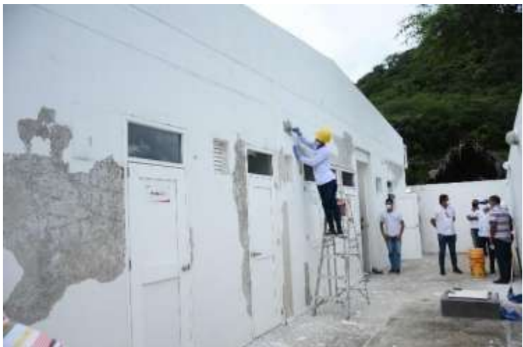
Fuente: Interventoría de Obras
