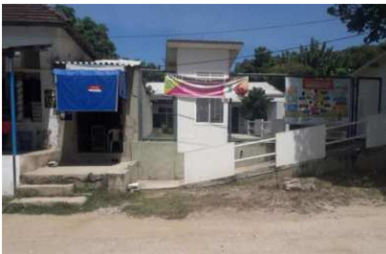
Puesto de Salud de Arroyo de Piedra ANTES
