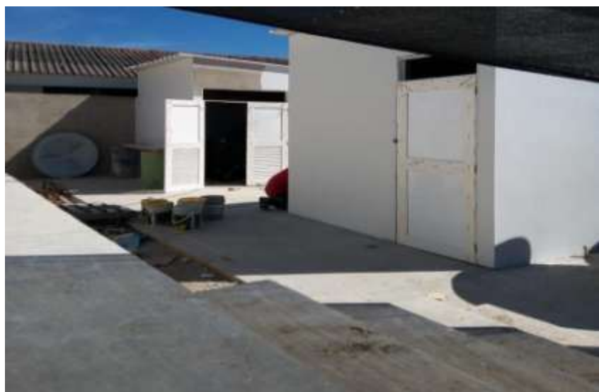
Fuente: Interventoría de Obras
