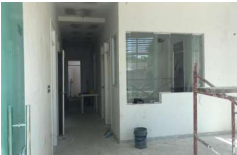
Fuente: Interventoría de Obras
