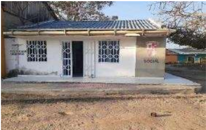
Fuente: Interventoría de Obras
