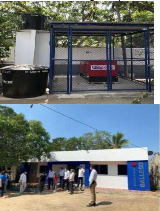
Fuente: Interventoría de Obras
