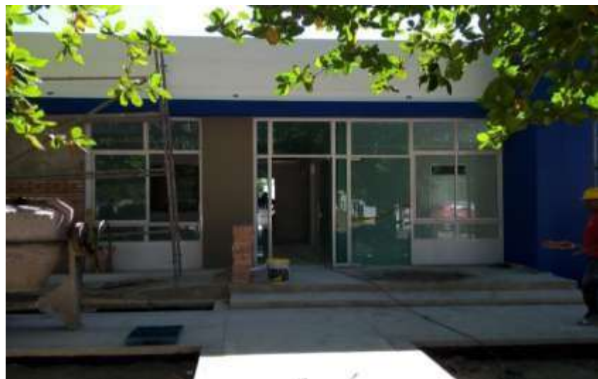
Construcción ESE Hospital de Candelaria Sede Leña
