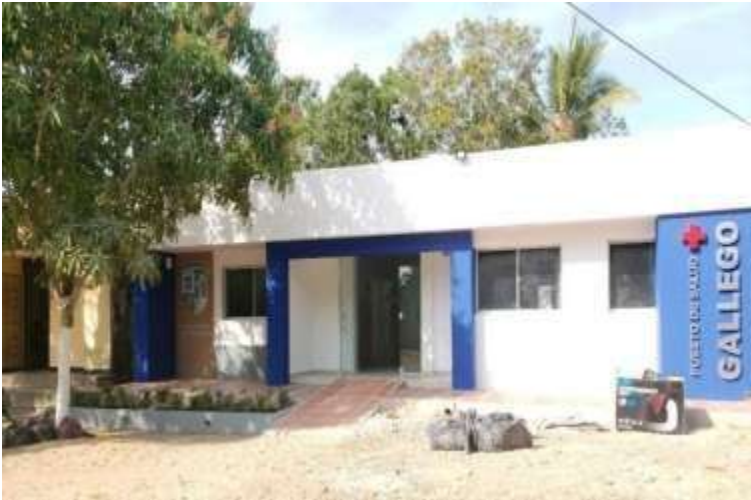
Fuente: Interventoría de Obras
