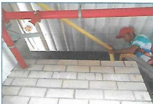
Instalación de tubos para la emisión de gases del Sistema de alcantarillado.
