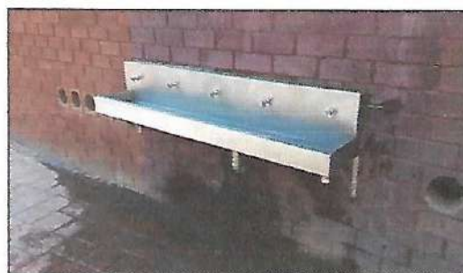
Instalación de fuente de agua a través de convenio con la alcaldía municipal.
