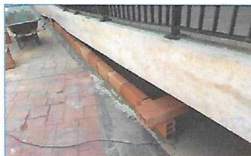
Mejoramiento zona de acumulación de basuras y malos olores.
