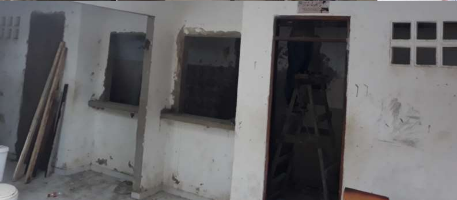
ADECUACIÓN TIENDA ESCOLAR
