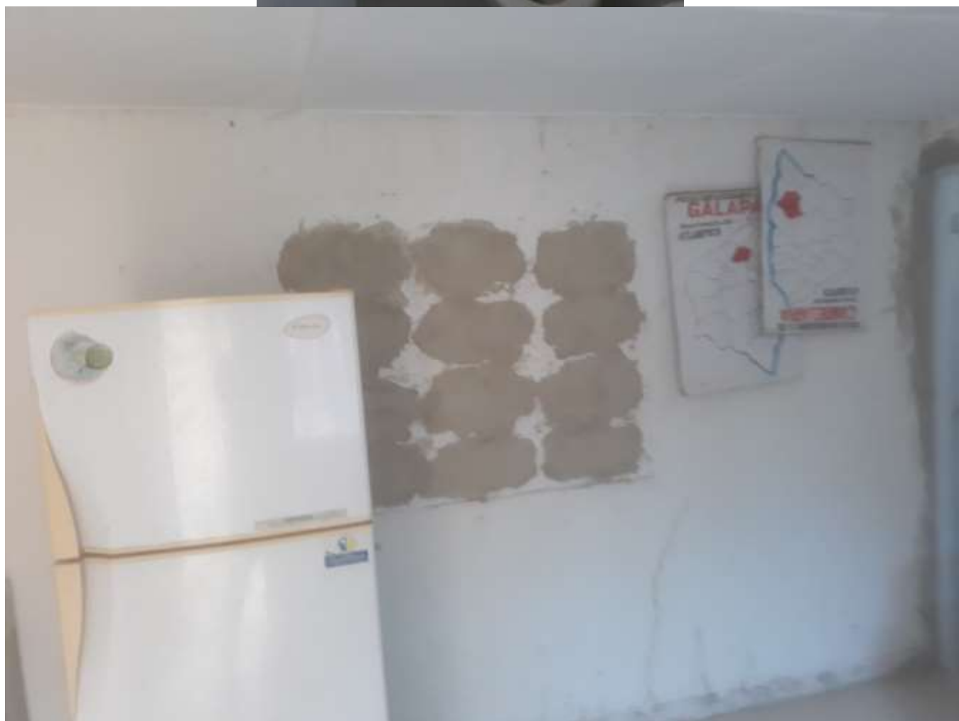
ADECUACIÓN DE BAÑOS Y OFICINA PRIMARIA
