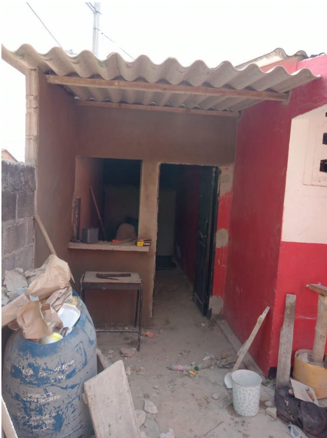
Adecuación de espacio para tienda escolar, Sede # 1
