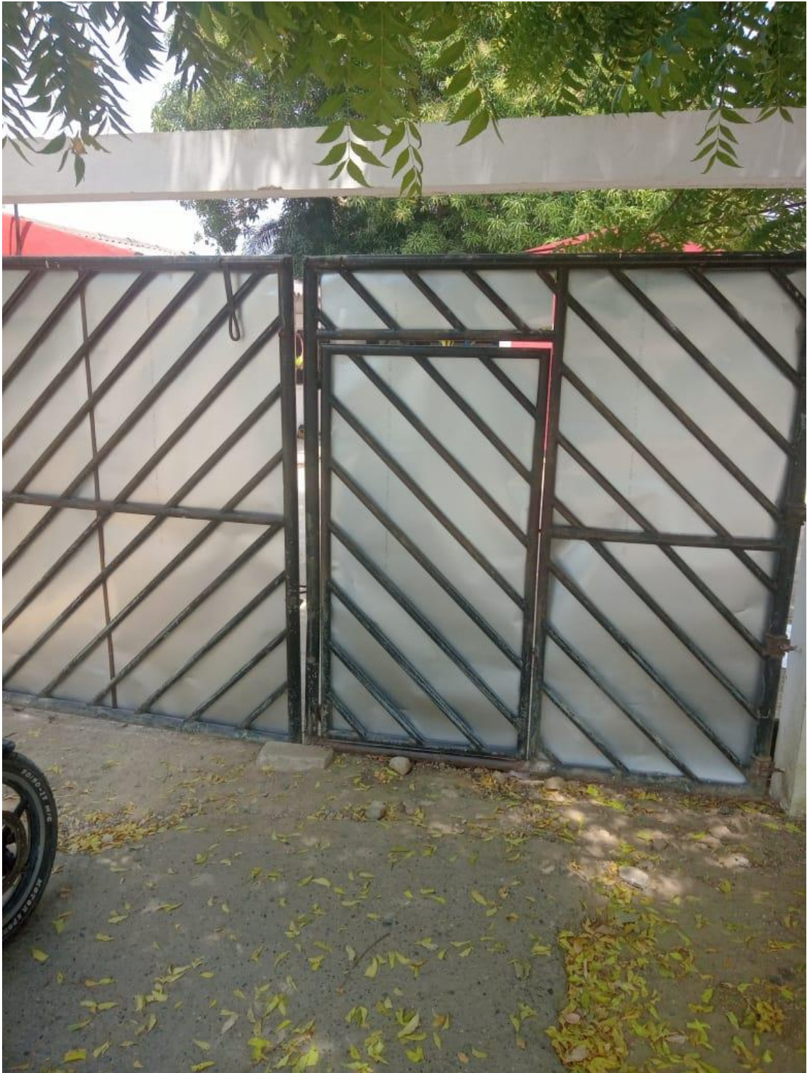
Cerramiento de portón principal, Sede # 3
