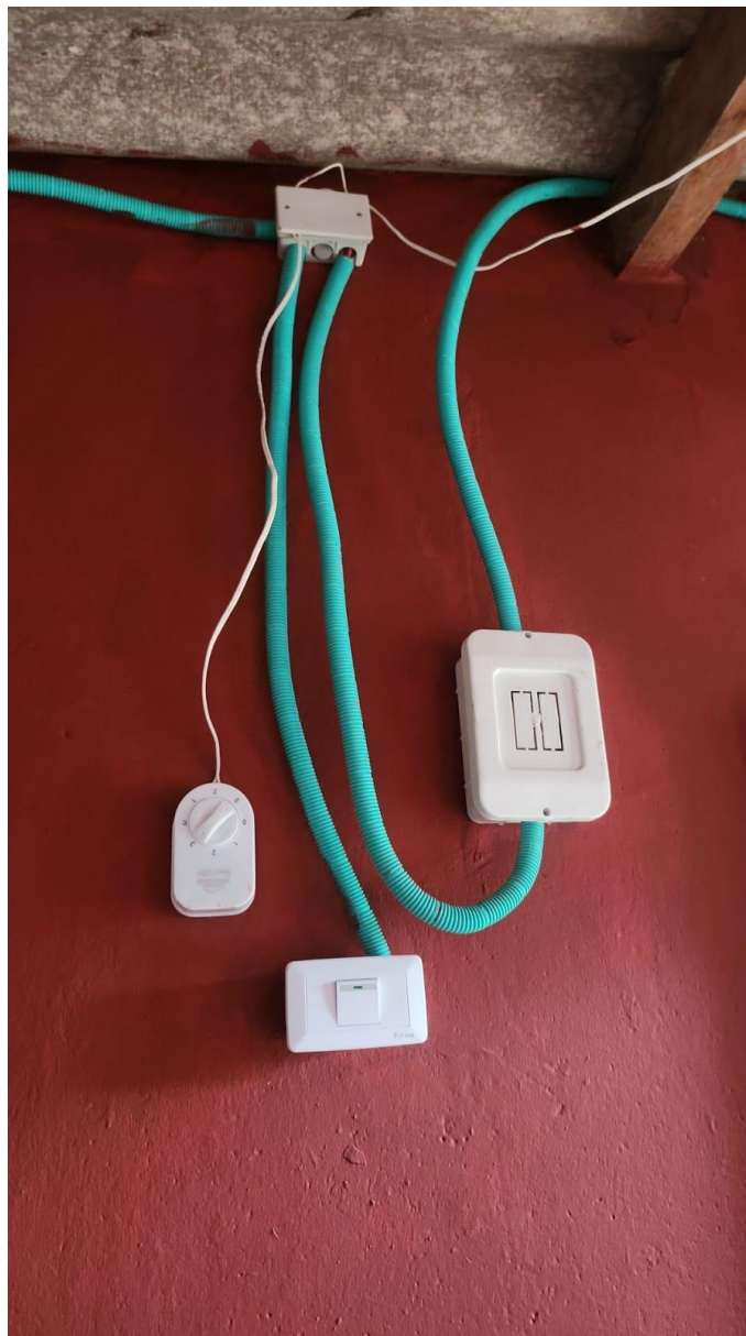
Mantenimiento redes eléctricas
