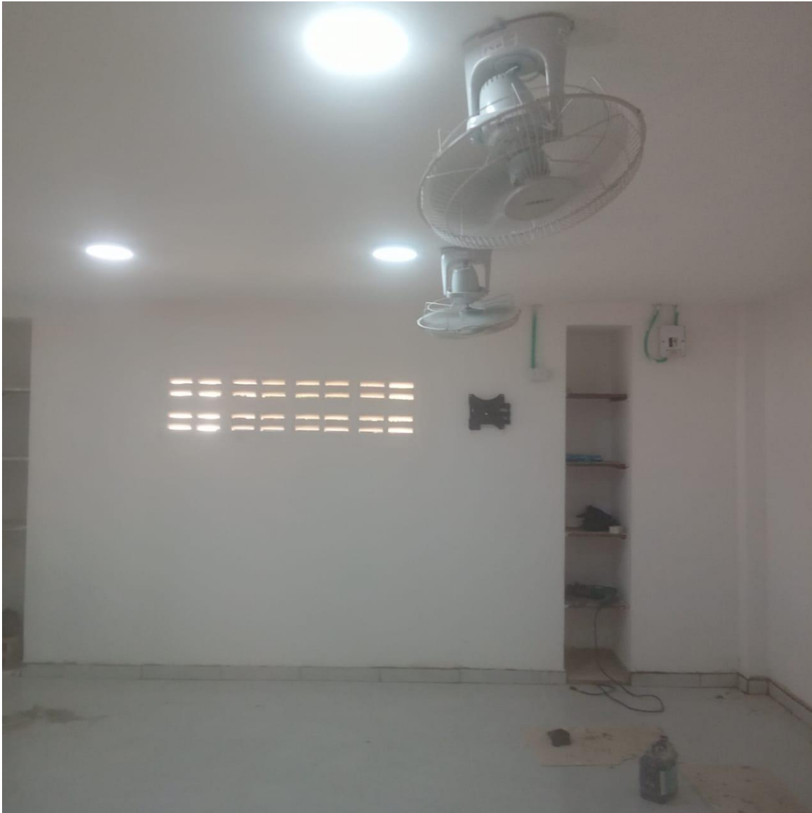
Adecuación aula primera infancia, sede # 4
