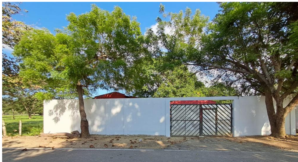
Recubrimiento en pintura fachada, Sede # 3
