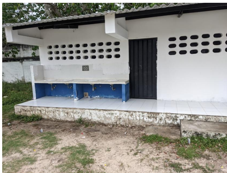
REPARACION DE BATERÍA DE BAÑOS.
