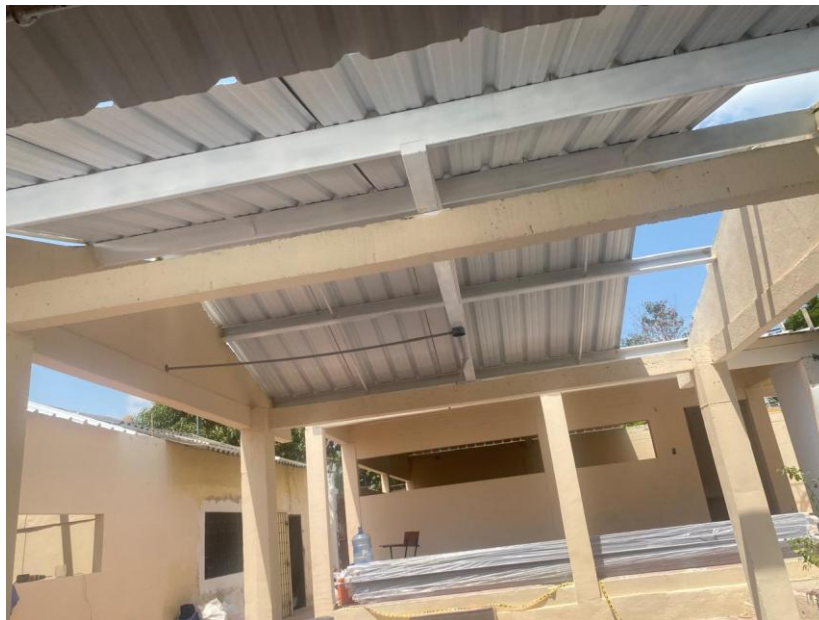
AVANCE DE TRABAJOS EN SEDE DOS PEDRO GOENAGA
