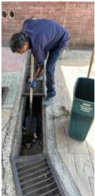
Limpieza y mantenimiento de de rejillas
