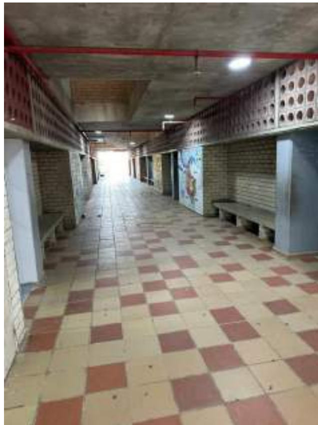
Cambio de lámparas quemadas en los pasillos del Bloque B y C
