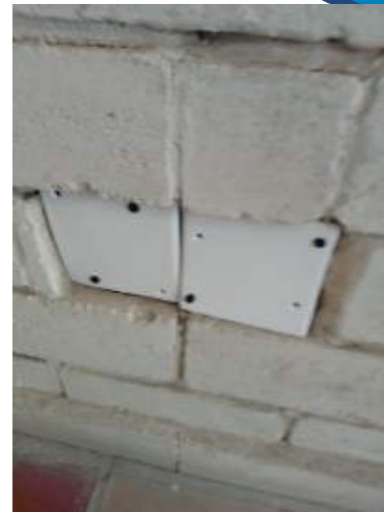
Colocación de tapas plásticas en registros eléctricos
