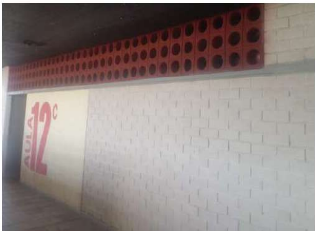
Pintura Bloque C y D
