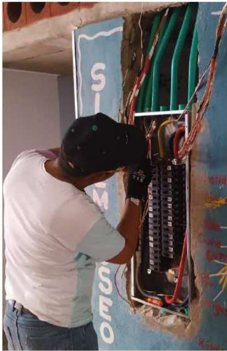
Cambio de Tablero eléctrico Bloque D
