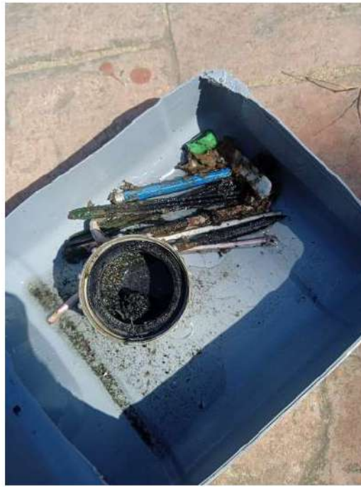
Destape de sifones de baños
