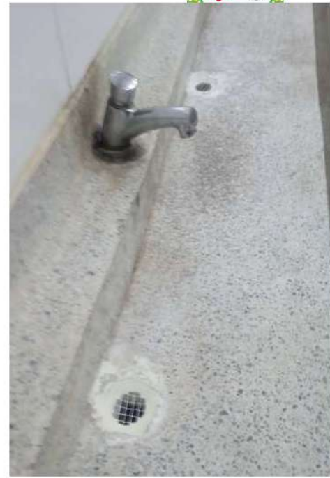
Colocación de mallas en lavamanos
