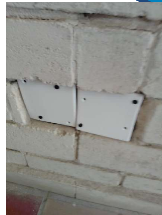
Colocación de tapas plásticas en registros eléctricos
