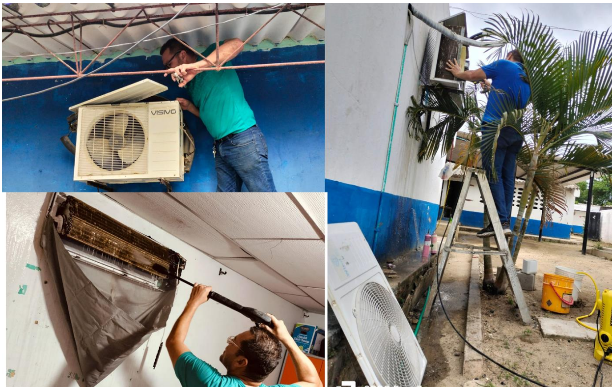
Mantenimiento de los aires acondicionados.
