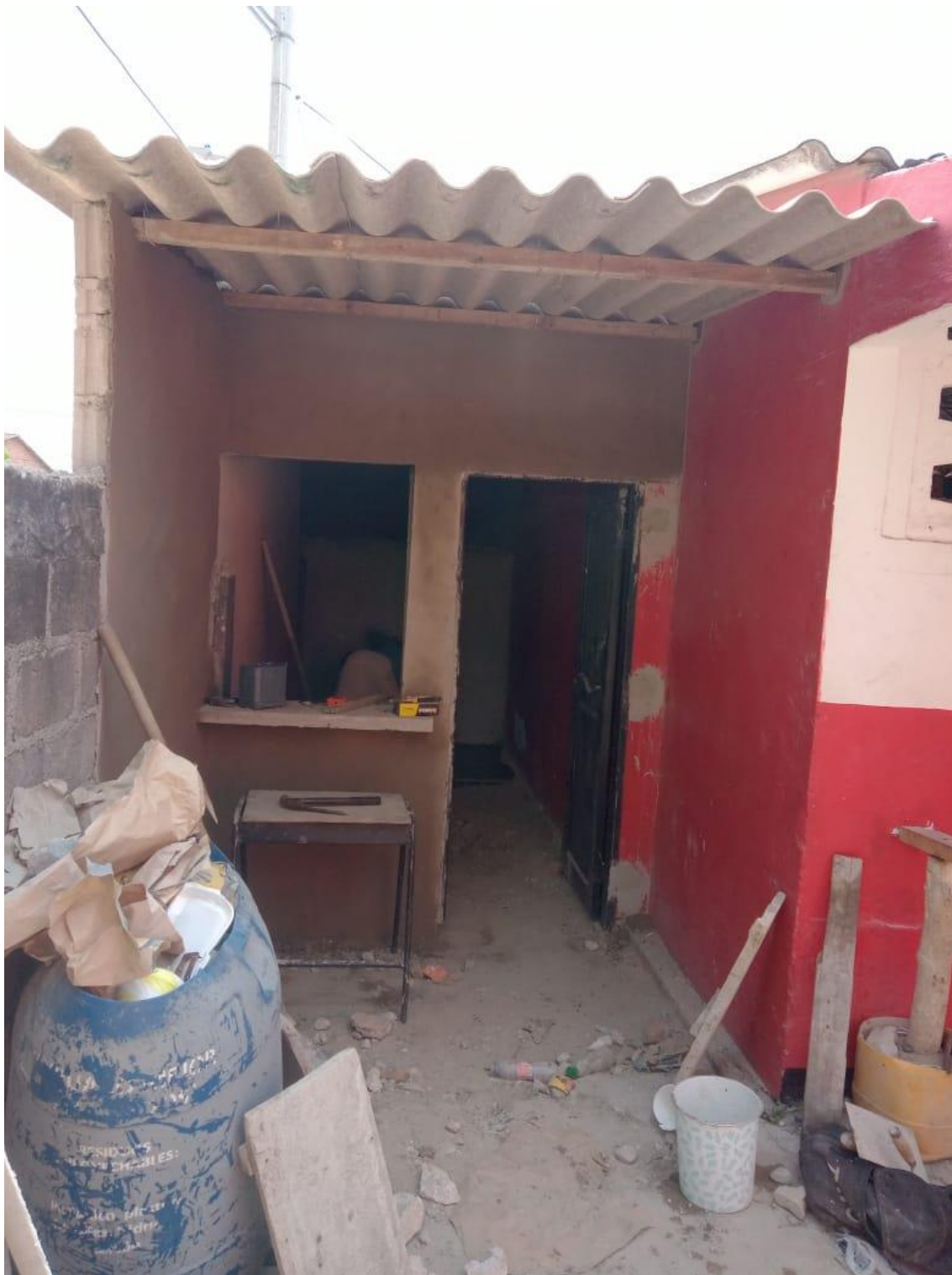
Adecuación de espacio para tienda escolar, Sede # 1
