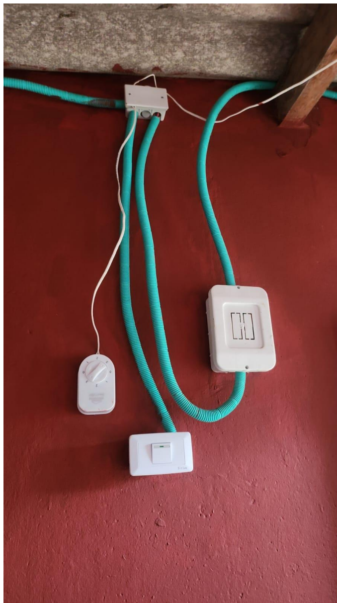
Mantenimiento redes eléctricas
