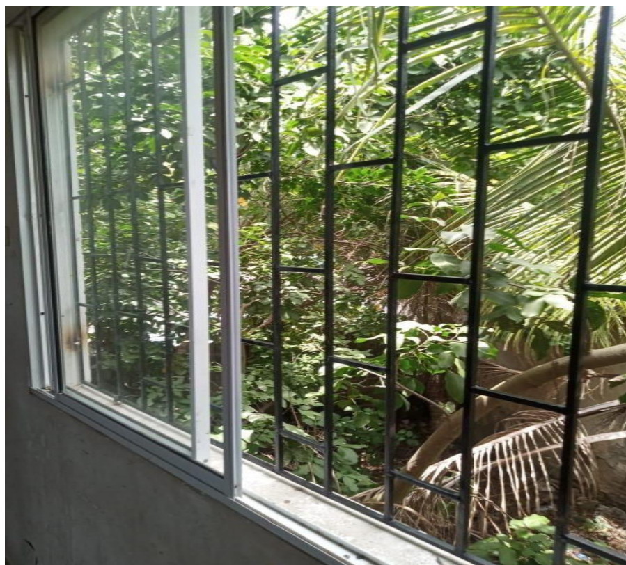
Restauración y/o pintura de silletería, mesas, puertas, rejas y barandas de seguridad
