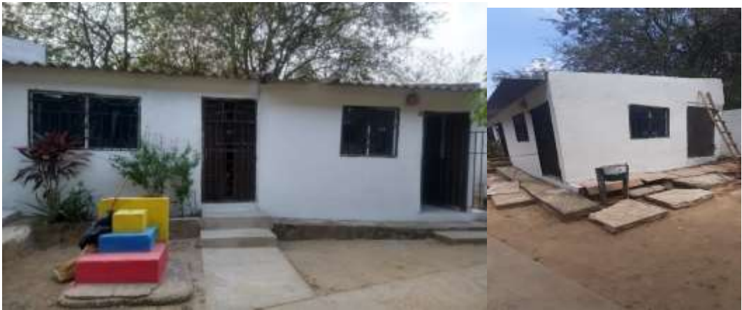
Imagen 52 mejoramiento fachada de espacio docente y coordinación
