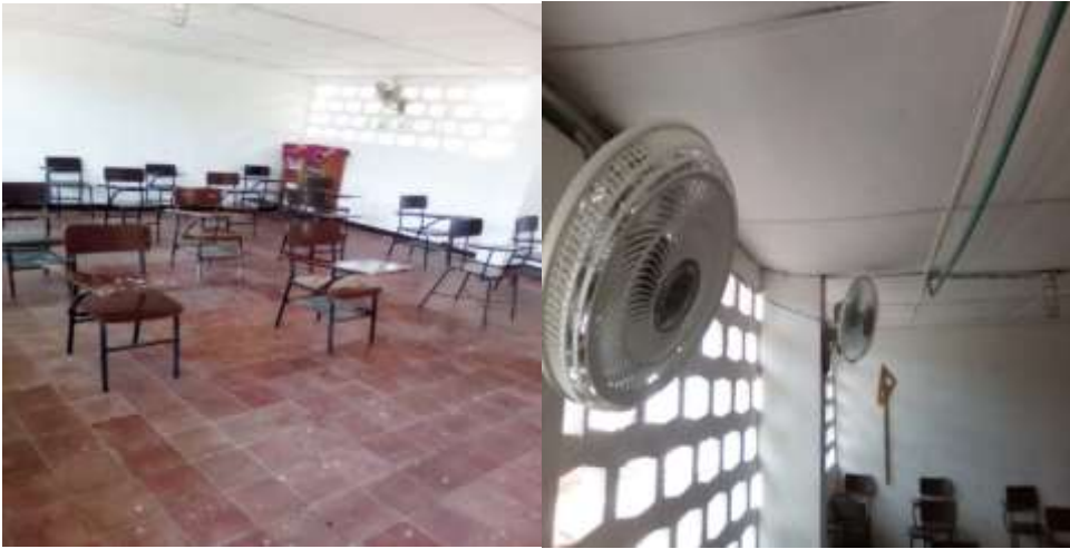
Imagen 44 después de trabajos de movimiento salón 1
