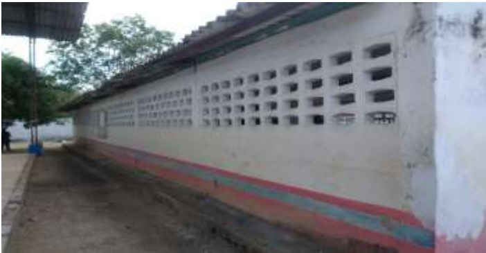
Imagen 43 antes de trabajos de movimiento salón 1 DESPUES
