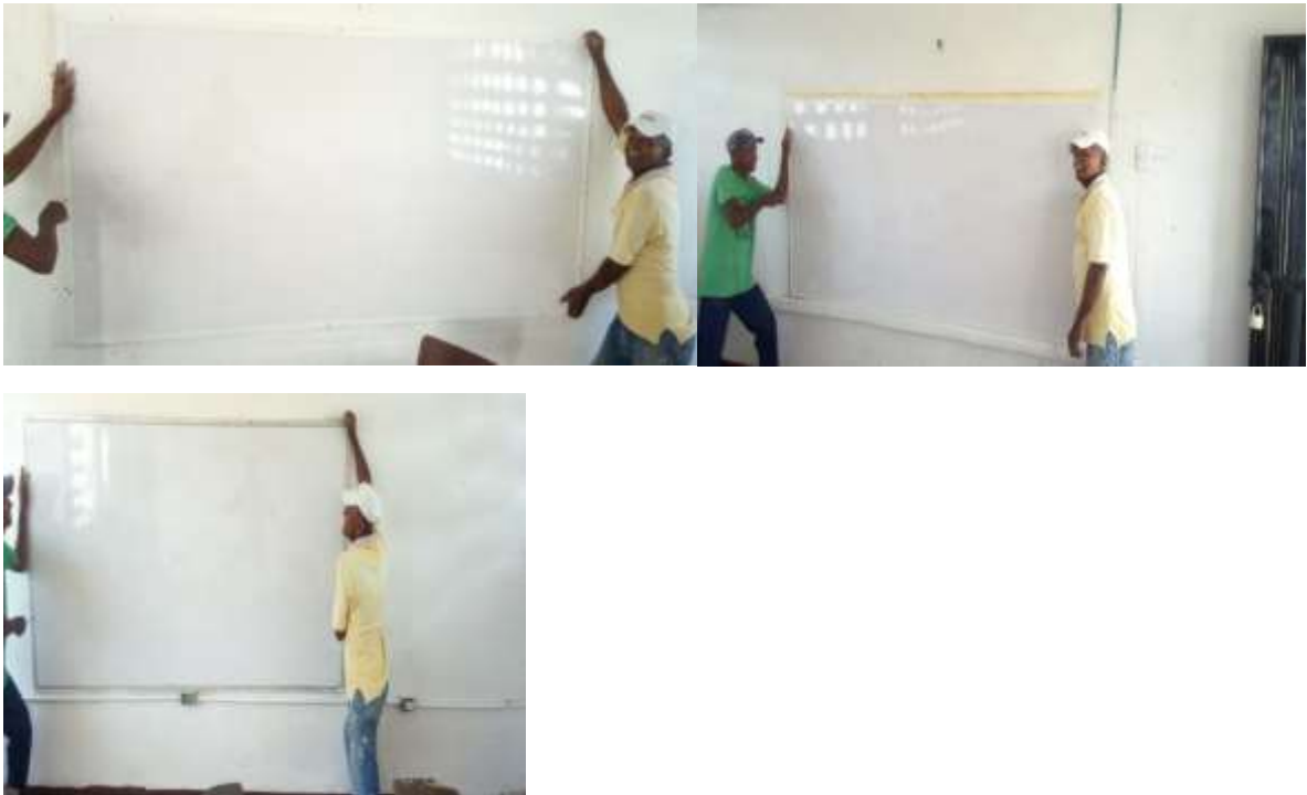
Imagen 60 postura de tres tableros acrílicos
