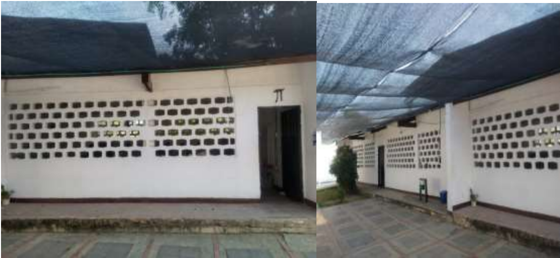
Imagen 45 parte frontal de salones después de mantenimiento
