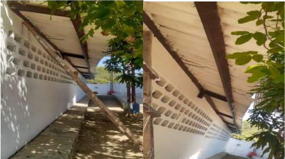
Imagen 46 parte posterior de salones después de mantenimiento
