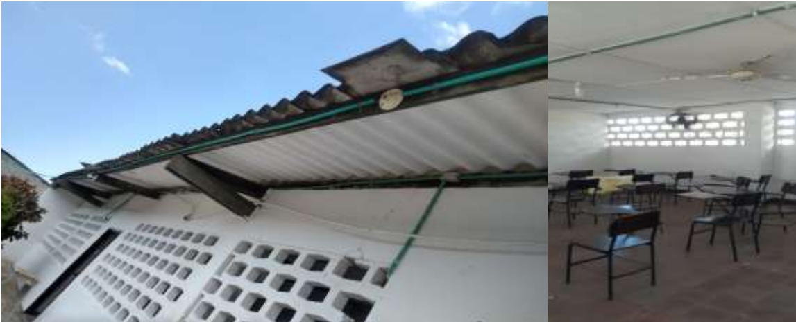
Imagen 42 después de trabajos de movimiento salón 2
