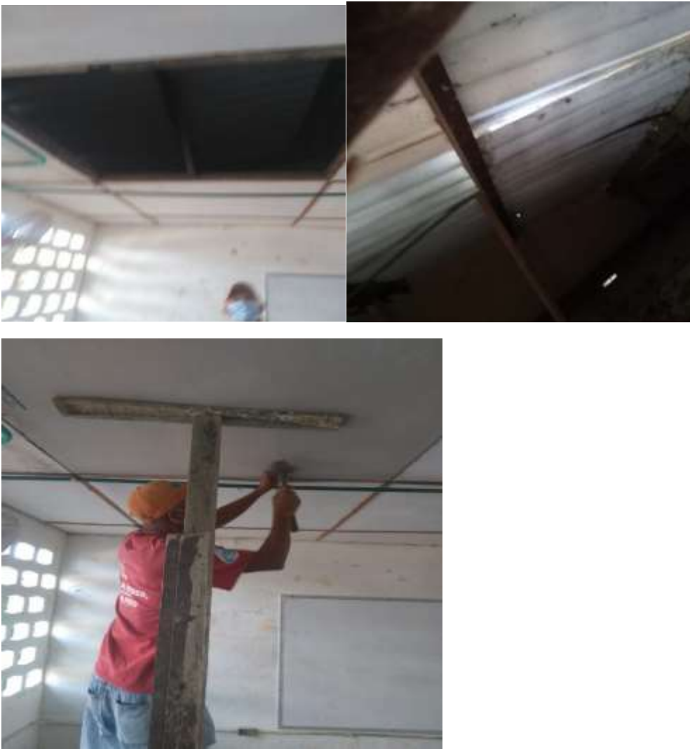
Imagen 47 Proceso arreglo de cielo raso de salones
