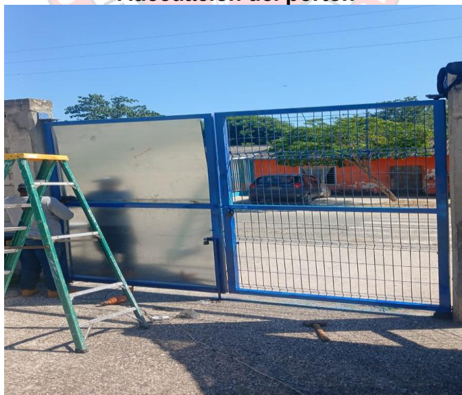
Adecuación del portón
