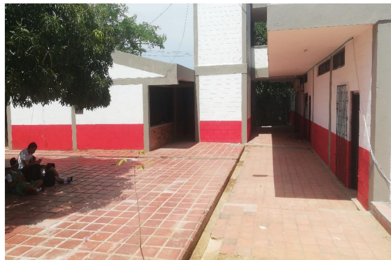
Arreglo y pintura de los Bloques que no fueron demolidos
