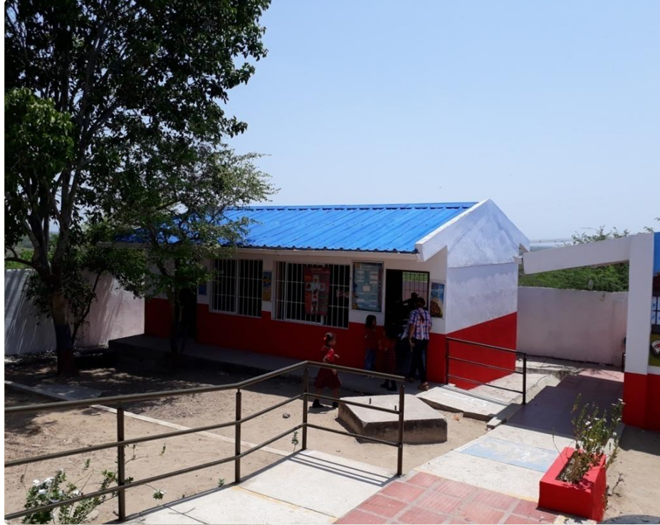
Adecuación de nuestra institución sede Mirador
