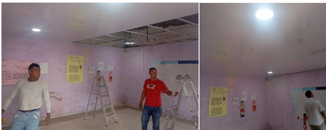
Instalación Cielo Raso Salones Bloque 3 (Sede 1 Bachillerato) 2025.
