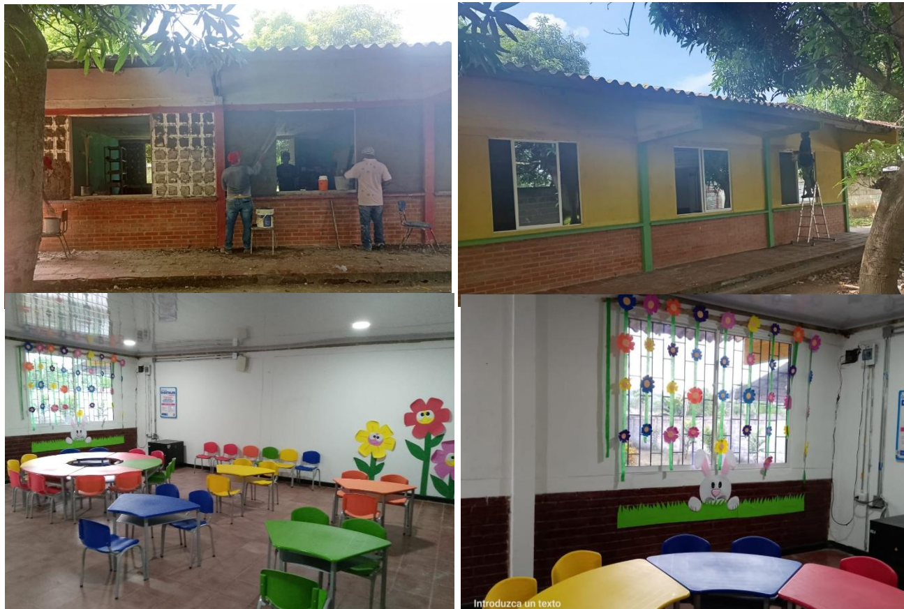
Remodelación sede N° 5 Pendales (Preescolar) 2025.
