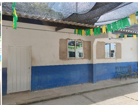
Instalación Ventanas Salón 11° – 2025.
