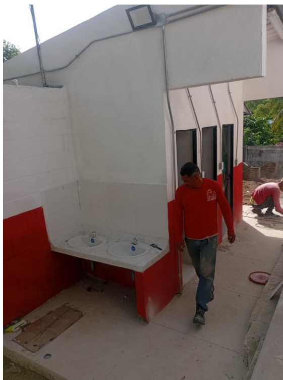
Trabajos Construcción y Remodelación Sede 3 Socavón – 2025.
