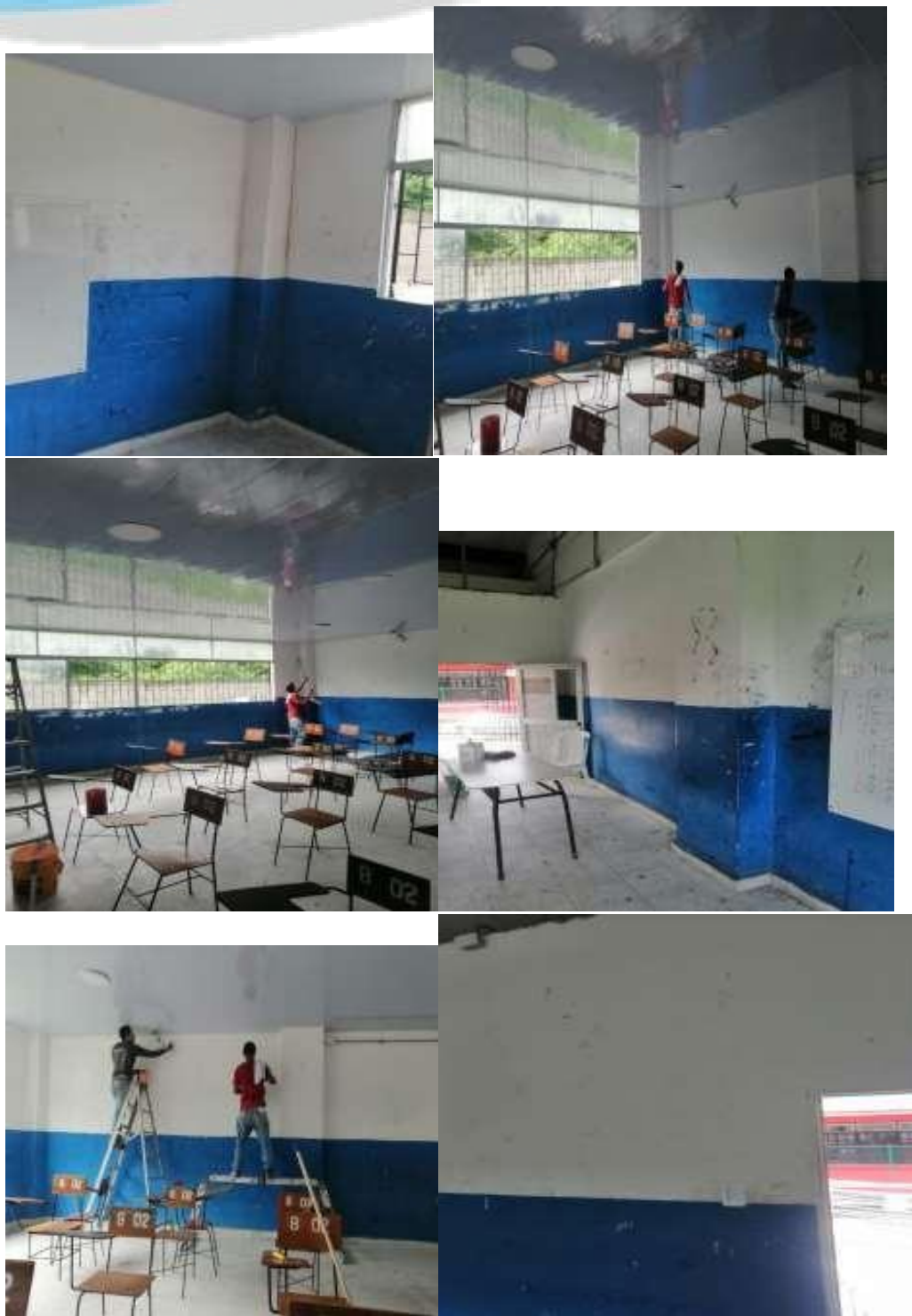
ESTADO INICIAL PINTURA INTERIOR AULAS
