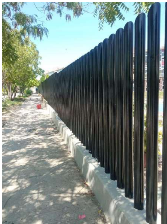
Mantenimiento Tubos externos de encerramiento
