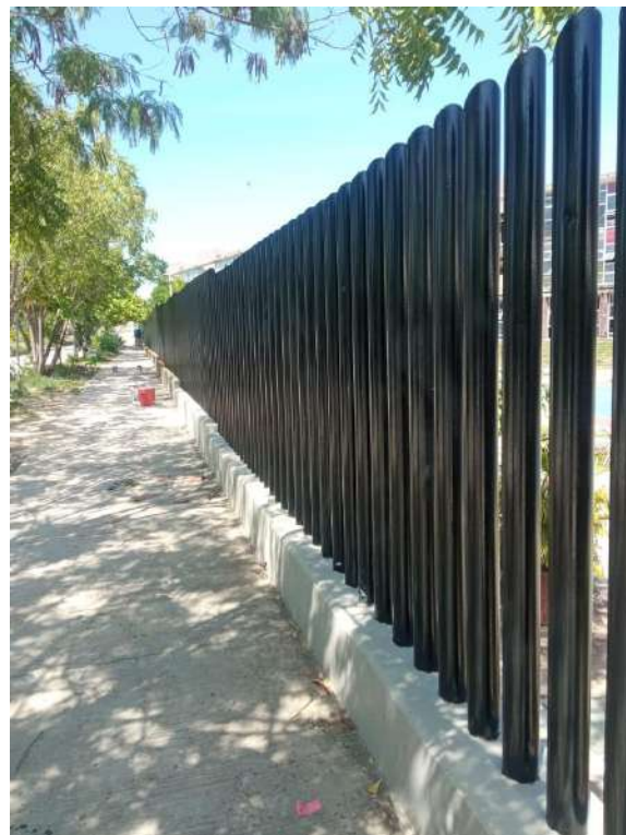
Mantenimiento Tubos externos de encerramiento
