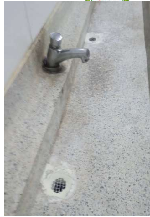
Colocación de mallas en lavamanos
