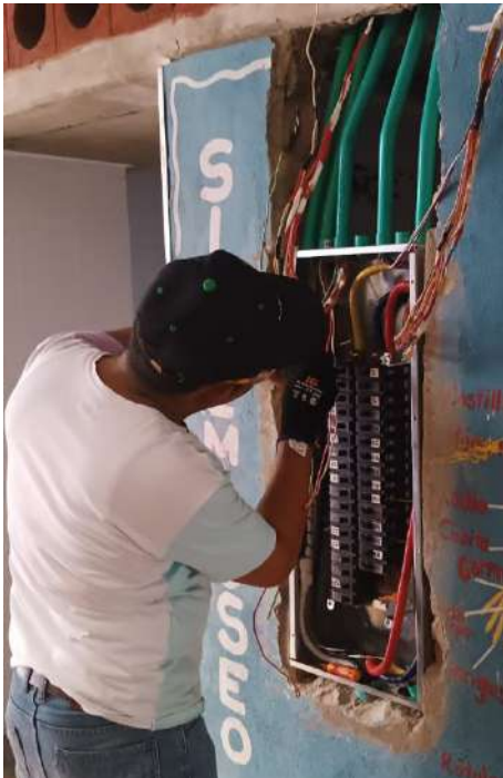
Cambio de Tablero eléctrico Bloque D
