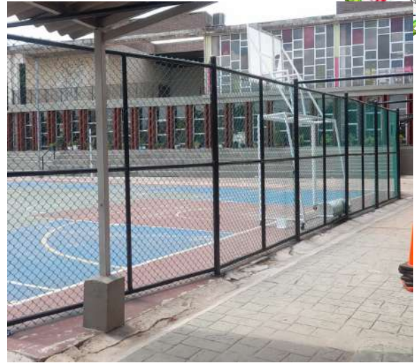
Cambio la Malla de Protección en la cancha principal (Después)
