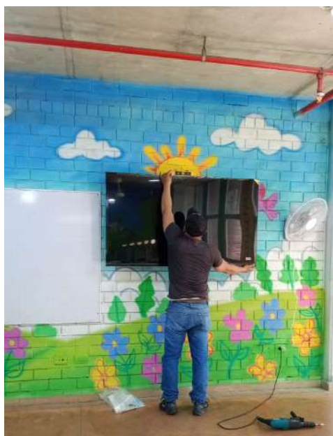
Instalación de Televisores en los Salones
