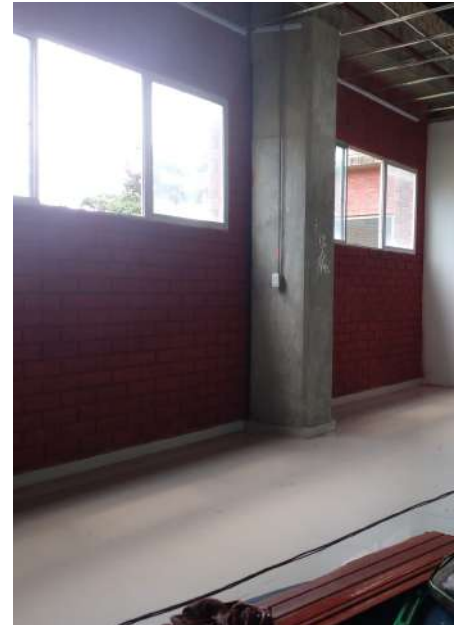
Adecuación de Sala de Profesores ( Pintura, cielo raso)
