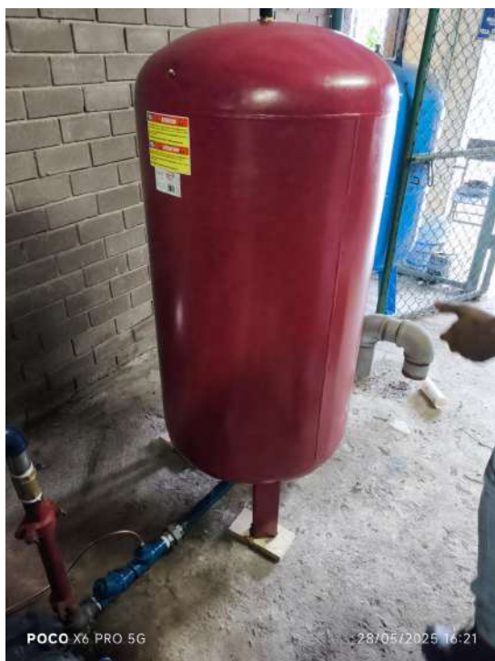
Cambio de tanque hidroneumático y mantenimiento al sistema automático de motobombas
