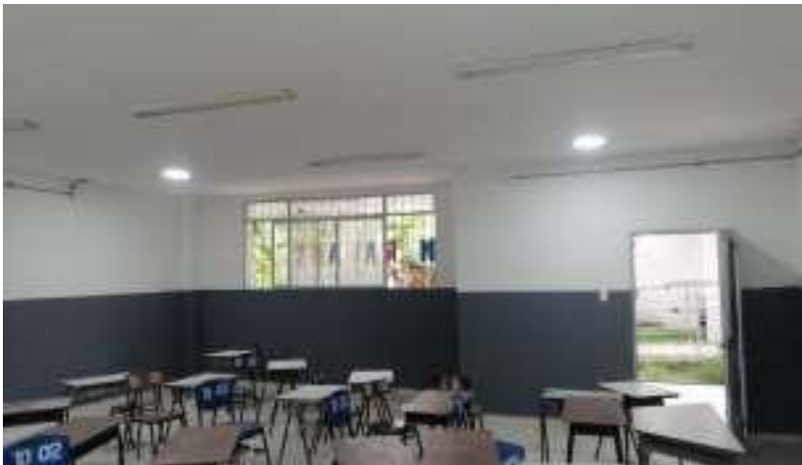
ESTADO FINAL PINTURA INTERNA AULAS DE CLASE
